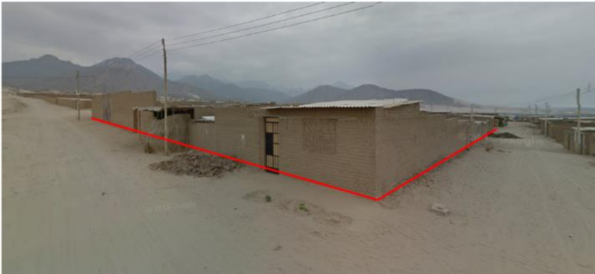
Ilustración 28. Vista de la vía vehicular
