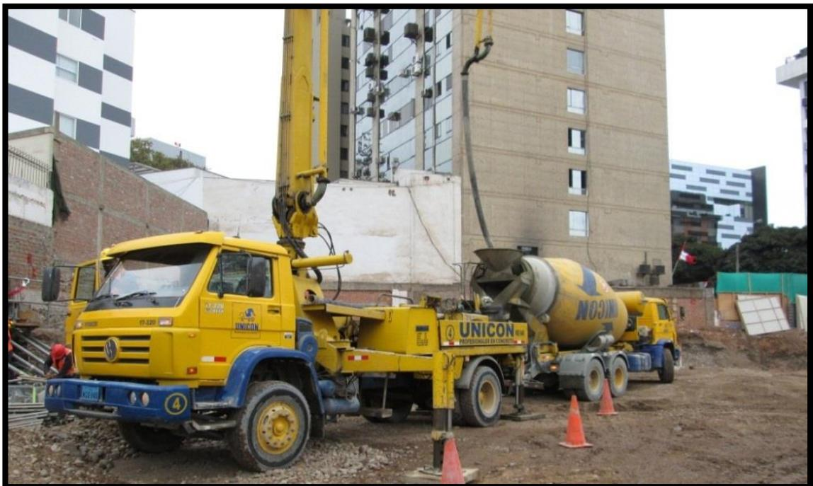
*Figura 81: Vaciado de muros*
