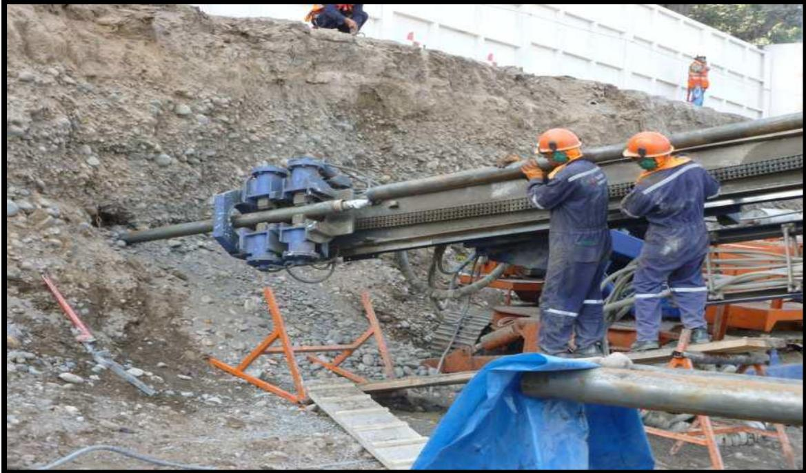
*Figura 78: Inyección de anclajes*
