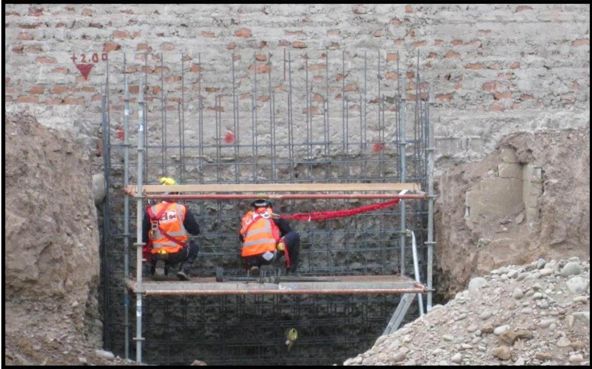
*Foto 7: Colocación de armadura de acero*
