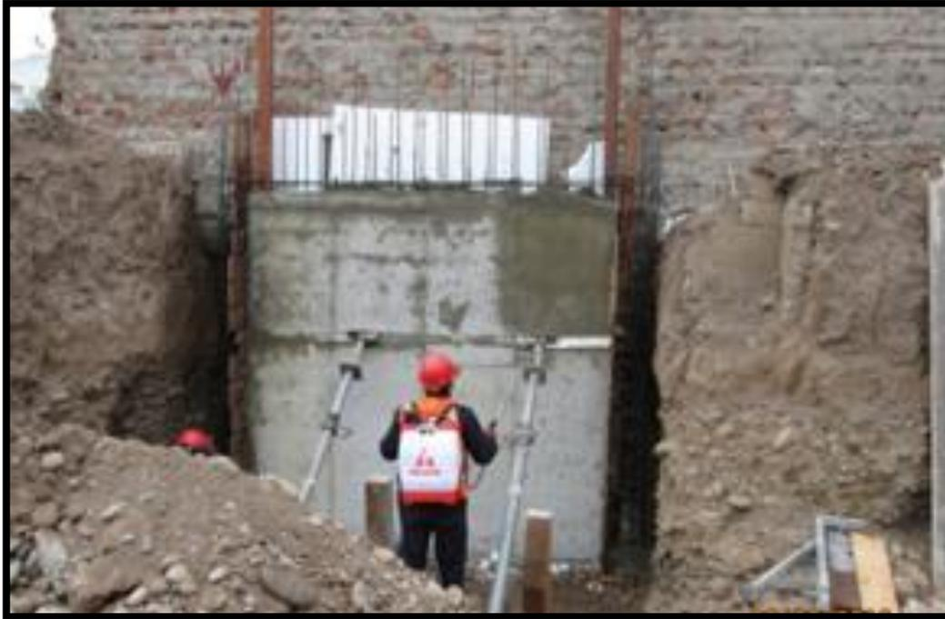
*Figura 82: Curado del muro con Antisol*
