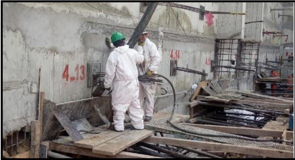
*Foto 9: Desencofrado de muros*
