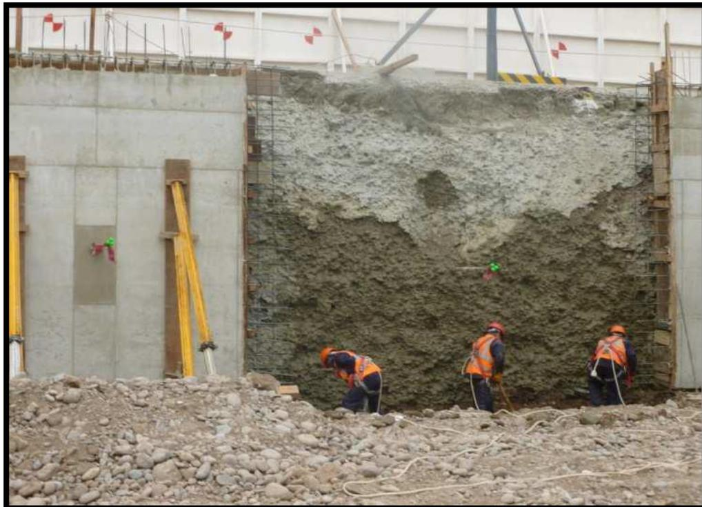
*Figura 83: Estabilización de terreno con lechada*
