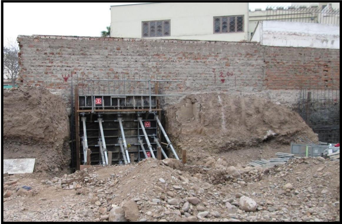
*Figura 80: Primer encofrado de paño de muro pantalla*
