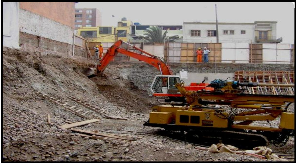
*Foto 5: Excavación primer anillo*
