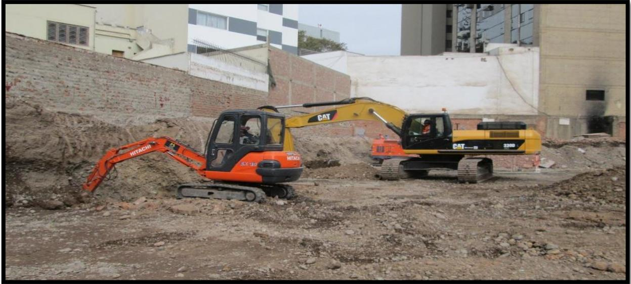
*Figura 76: Realización de Trabajos de Corte de Banqueta y Perfilado*
