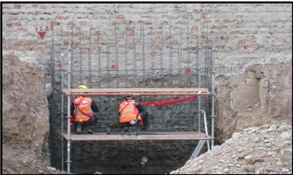
*Figura 79: Armado de acero en muros*
