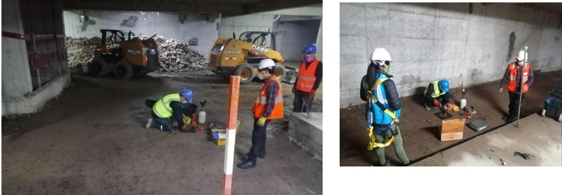
*Nota.* Se observa la ejecución del ensayo de densidad de suelo realizados en los sótanos a nivel de rasante y subrasante.
