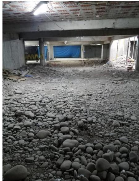
*Nota:* Nivelación topográfica del sótano para dar inicio a las partidas de rasante y subrasante.
