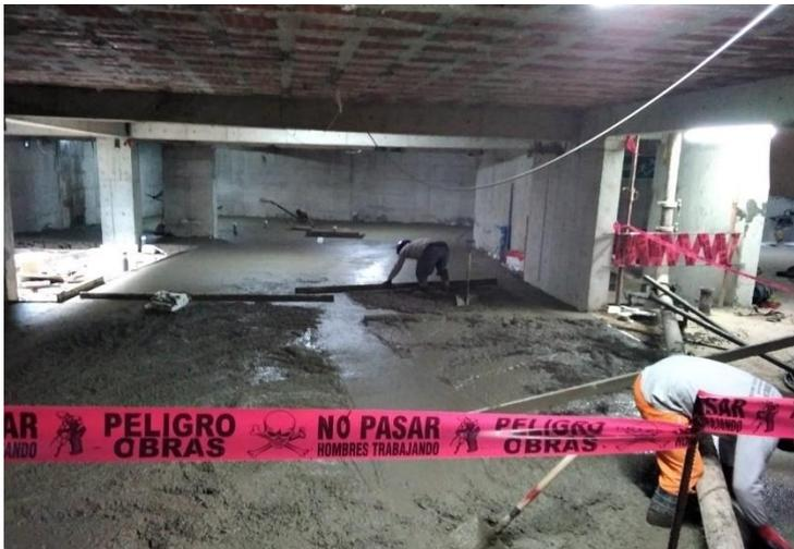
*Nota.* Se observa el vaciado de concreto simple en los sótanos 2 y 3.
