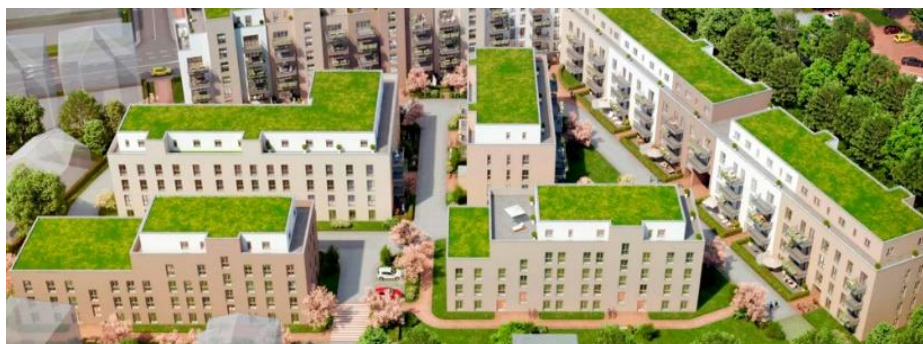
Figura 1. Nolltemeyer Hoefe, Alemania, residencial con techo verde de retención, que puede almacenar grandes cantidades de agua en caso de lluvia intensa y permitir que se drene al sistema de alcantarillado con un retraso de tiempo. Adaptado de Arcguide ( https://acortar.link/5oV7av ), 2021.
