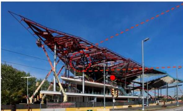
La estructura de cada módulo soportado por cuatro pilares se organiza en 6 vigas principales: las cuatro que delimitan su perímetro, de morfología más o menos rectangular, y las dos diagonales.
