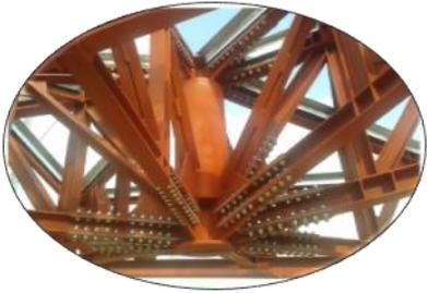
**NUDOS CON 12 PERFILES CONCÉNTRICOS DE LA CUBIERTA METÁLICA**
