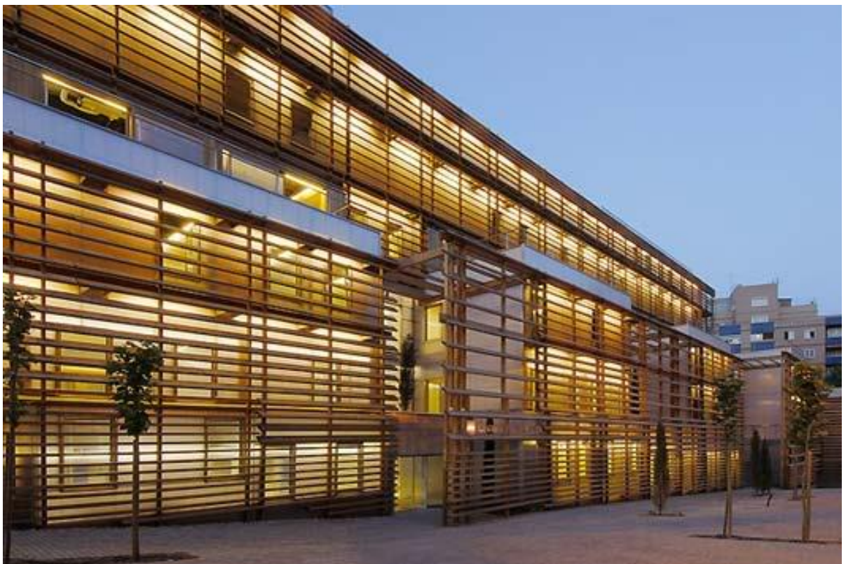
Figura 1: Vista general del caso 01
