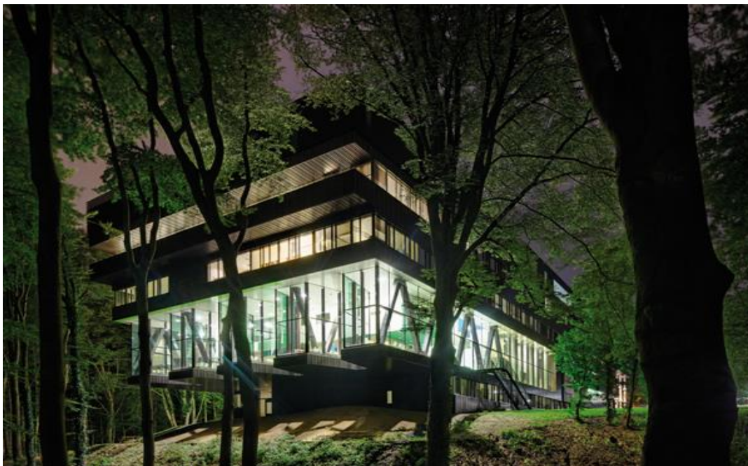
Figura 2: Vista general del caso 02
