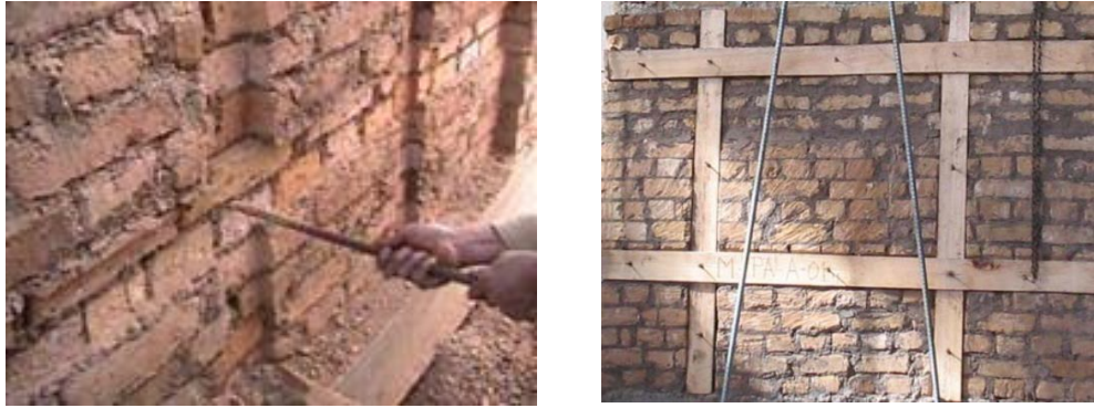
Figura 13: Muro de adobe reforzado con madera. Fuente: Recopilado de AIS, 2010.
