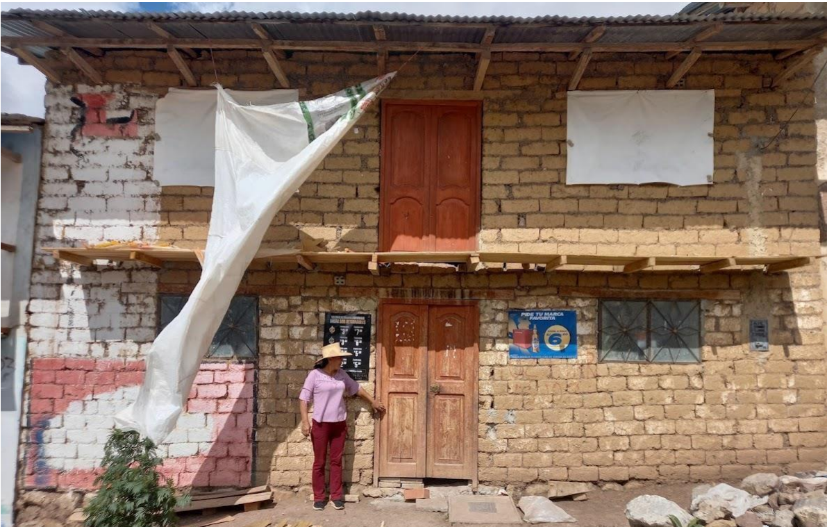
Foto N.º 4: Vivienda (2) de dos pisos de adobe sin ningún tipo de refuerzo, construida con técnicas adquiridas de sus ancestros.
