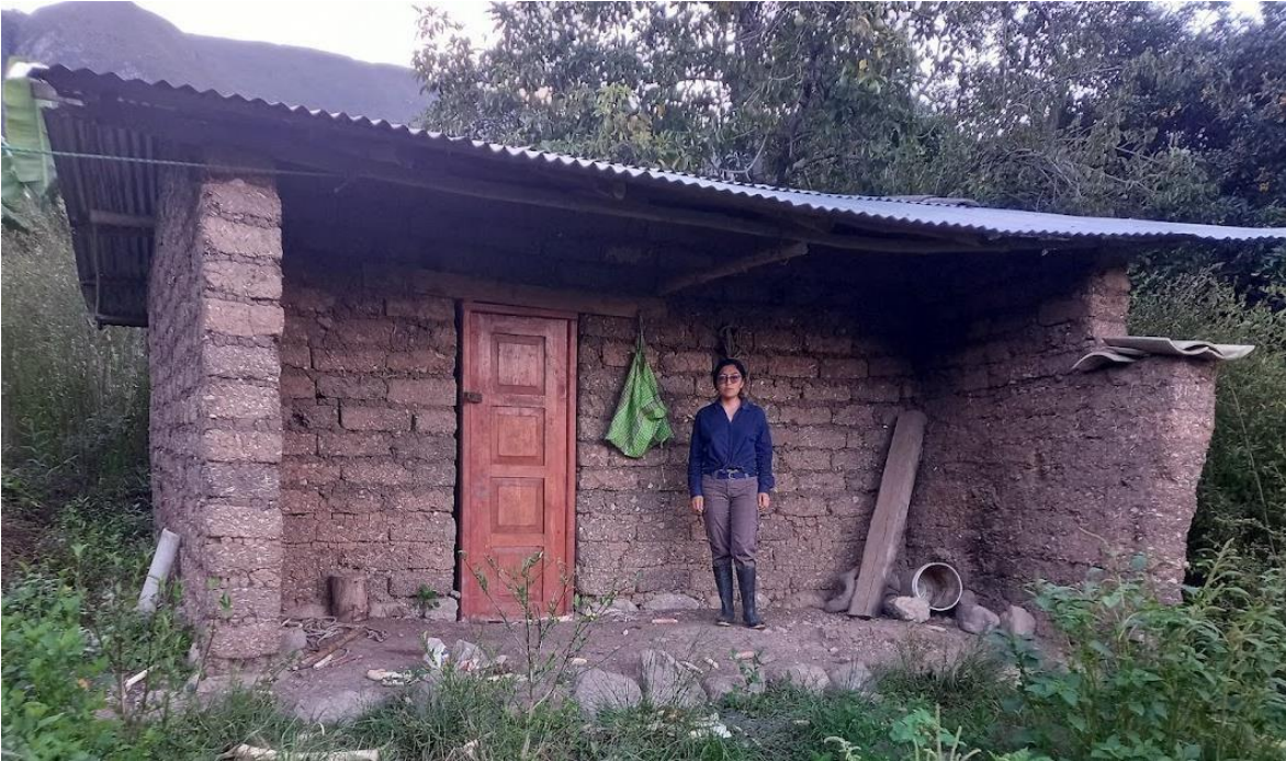
Foto N.º 9: Vivienda (7) de adobe se evidencia poca iluminación, ya que cuenta con solo una puerta y no cuenta con ventanas.
