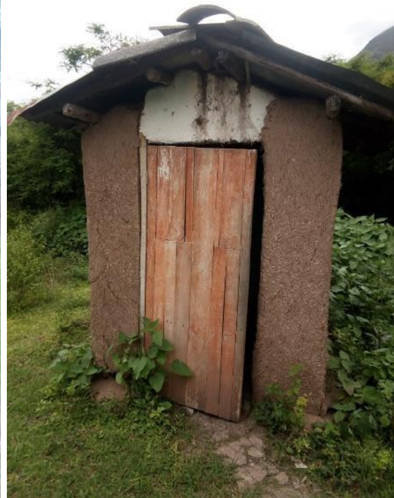
Foto N.º 10: Letrinas a base de adobe, la estructura presenta fallas en los muros.
