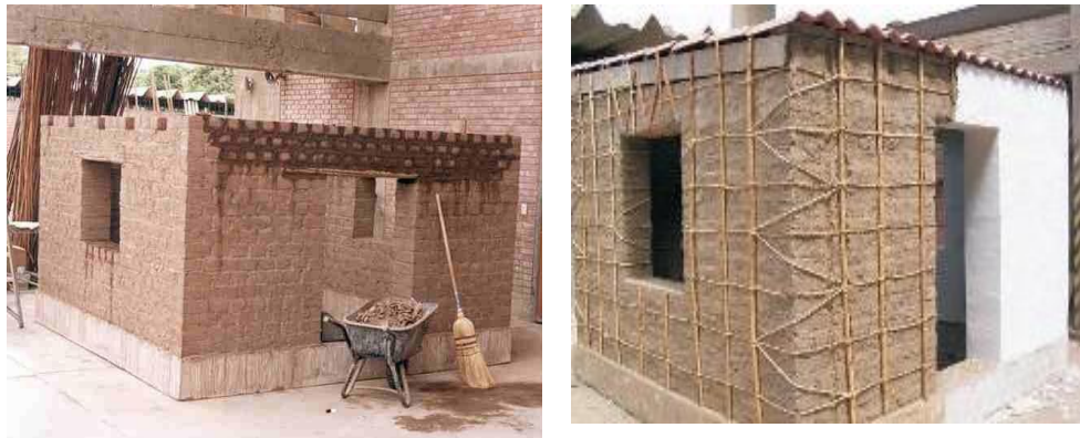
Figura 12: Muro de adobe reforzado con malla natural.
