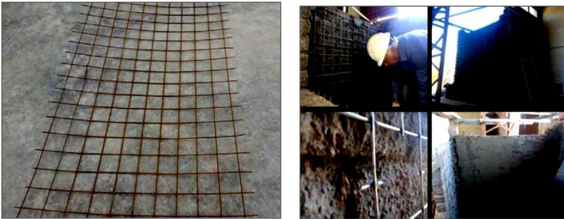
Figura 14: Malla electrosoldada y colocación como refuerzo de muro de adobe.
