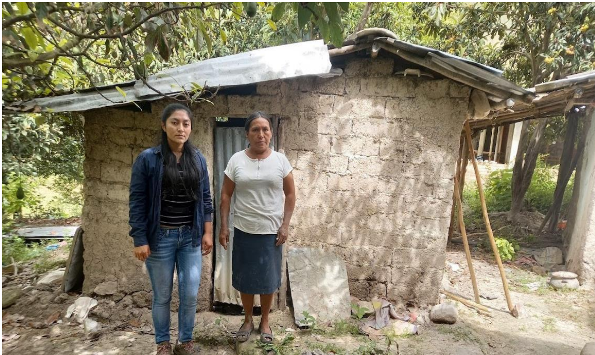
Foto N.º 8: Vivienda (6) de adobe presenta evidencia de la técnica de construcción hecha por los mismos pobladores de la zona adquirida de sus ancestros.
