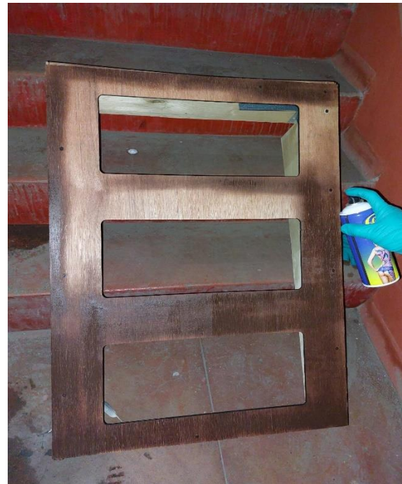
Nota: Construcción de la estructura para el prototipo de techos verdes en bandejas livianas.
