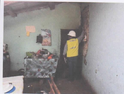
Medición de interiores con distanciómetro
