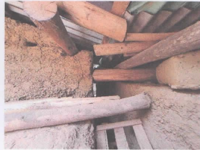
Separación (junta) con vivienda colindante
