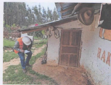
Amálisis y verificación de los muros en la vivienda
