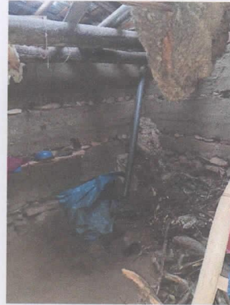
Interior de vivienda, con muros en buen estado
