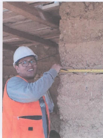
Medición ancho de muro con wincha
