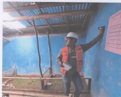
Medición con distanciómetro Laser en interiores
