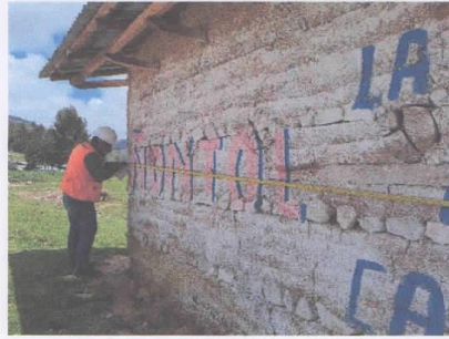
Medida perimetral con wincha
