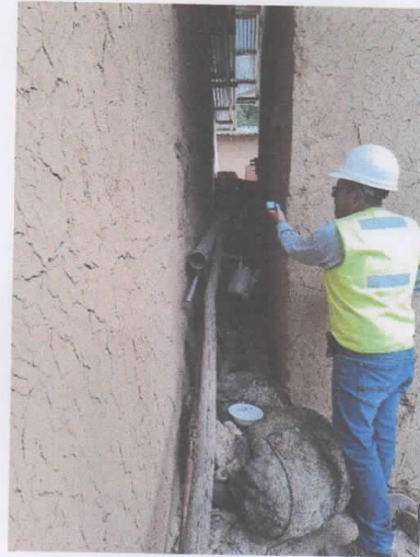
Separación (junta) con la vivienda colindante
