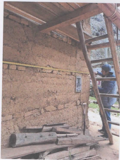
Medición perimetral con wincha
