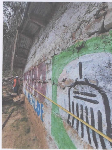
Medición perimetral con wincha
