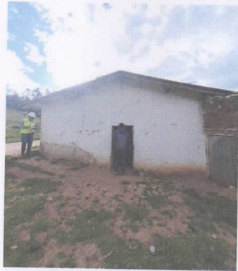
Frontis de la vivienda N°11 (IGLESIA)
