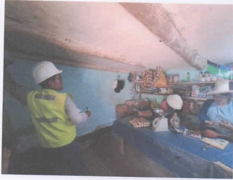
Medición con distanciómetro Laser en interiores
