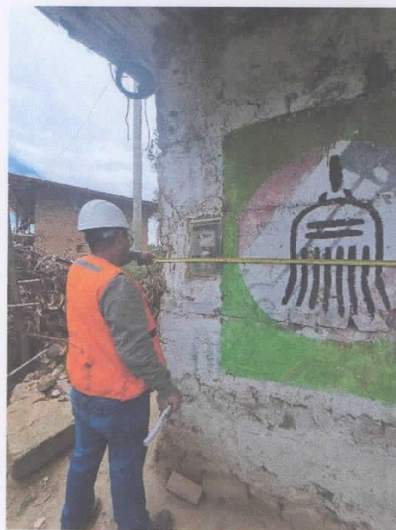
Medición perimetral con wincha
