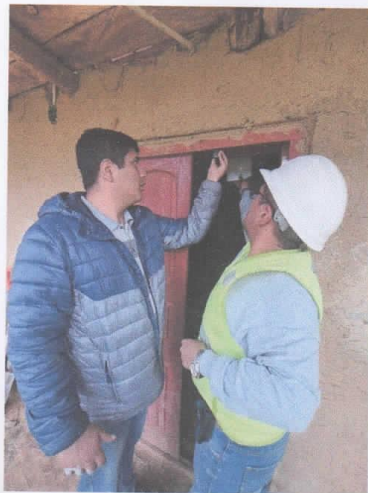
Medición de ancho de muros
