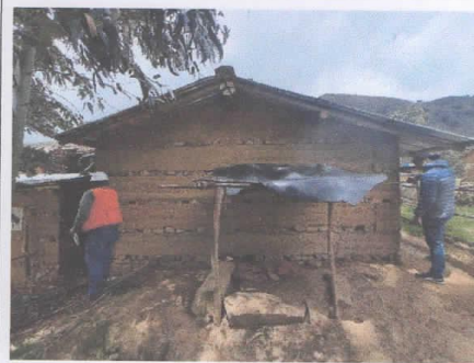
Medida perimetral con wincha
