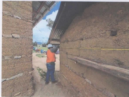
Medida perimetral con wincha
