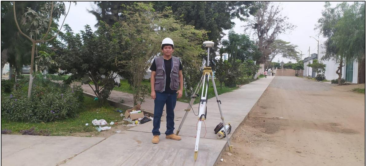
Posteriormente se procedió a instalar la Estación Total en el BM previamente calculado, para iniciar el levantamiento topográfico.
