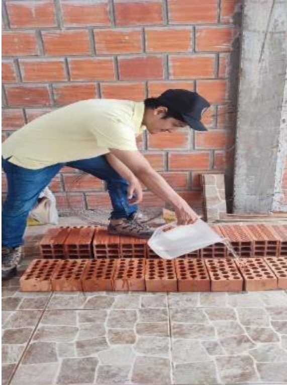
ANEXO N°5. Proceso de elaboración de muretes con 1.5 cm de junta
