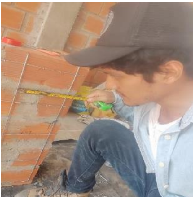
ANEXO N°6. Reforzamiento con malla electrosoldada en muretes de pandereta y King Kong
