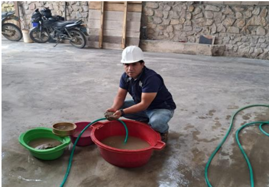
Figura 26. Lavado de arena.
