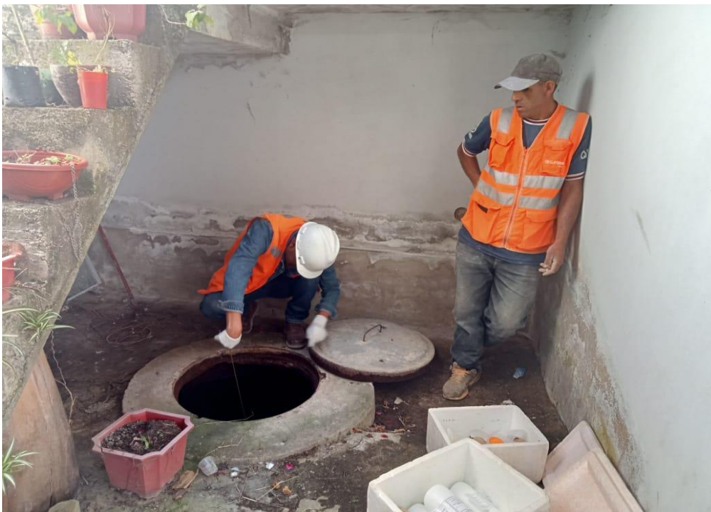
Foto 2: Realizando las medidas (Diámetro, Profundidad y Nivel de agua).
