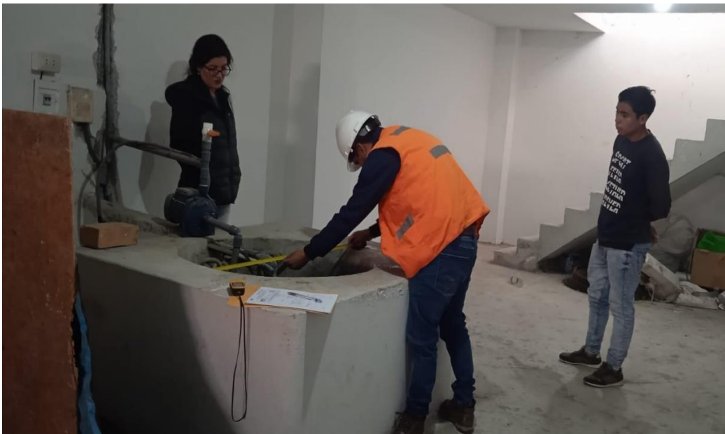
Foto 9: Tomando medidas de las dimensiones del pozo 03.
