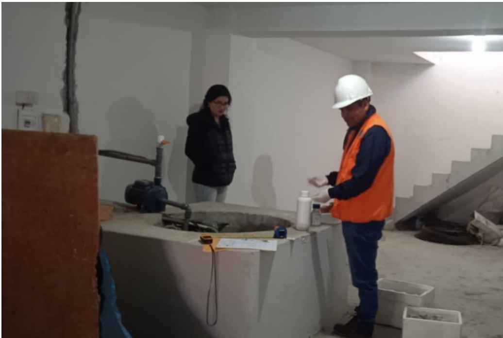
Foto 8: Realizando la toma de muestras de agua del pozo 03.
