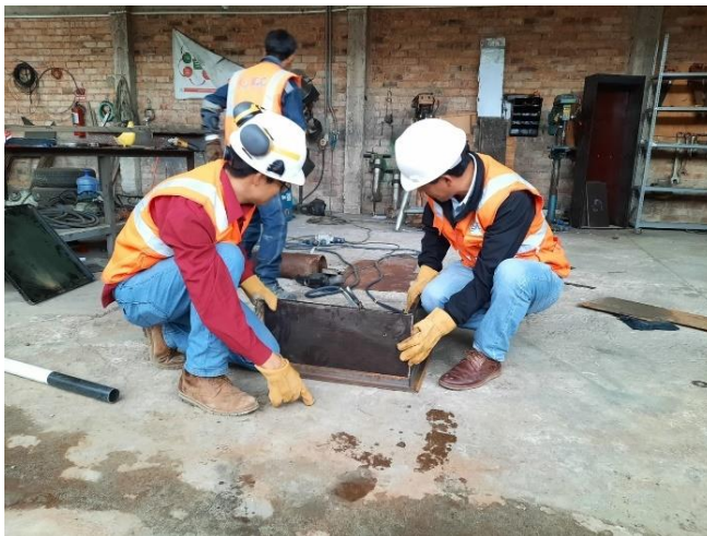
Figura 24 Construcción de Estructura.
