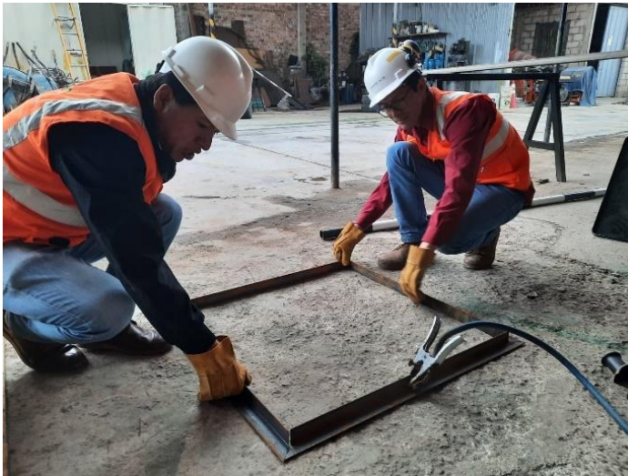
Figura 23 Soldadura de Base.
