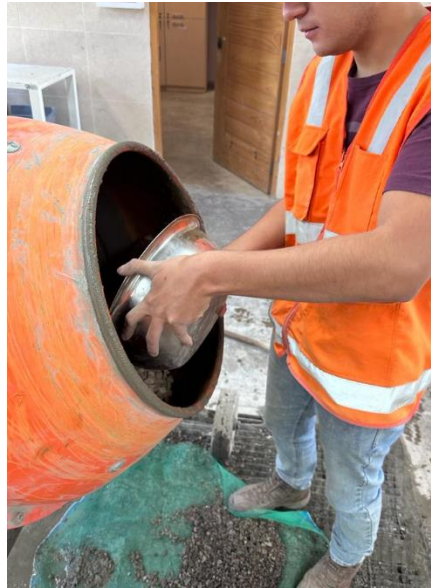
Figura 9. Proceso de mezcla del concreto.
