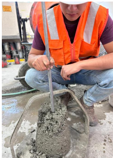
Figura 10. Medida del asentamiento del concreto (SLUMP).
