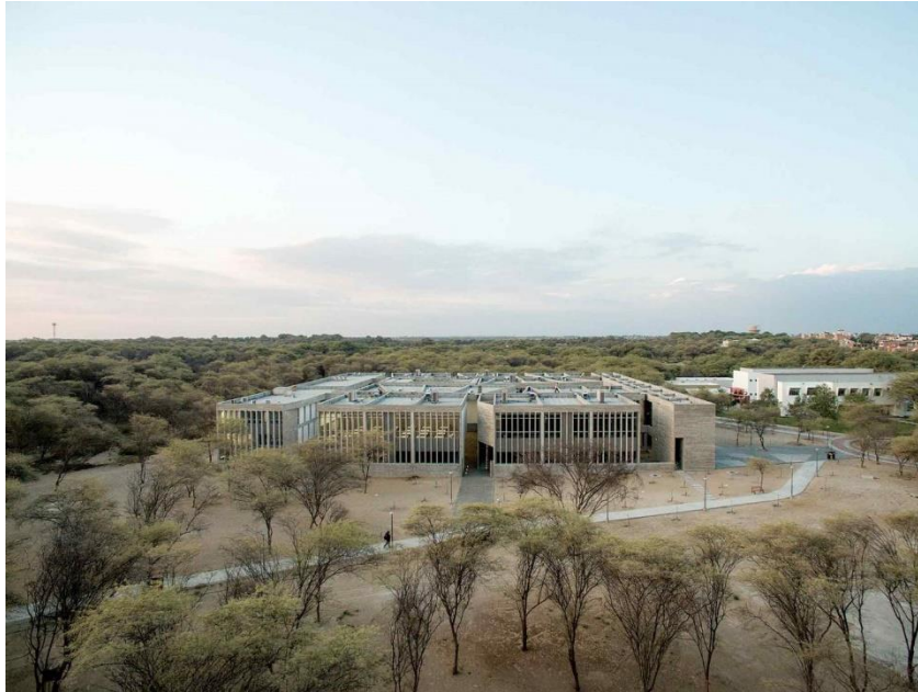
Figura n.º 4. Aulario de la Universidad de Piura
