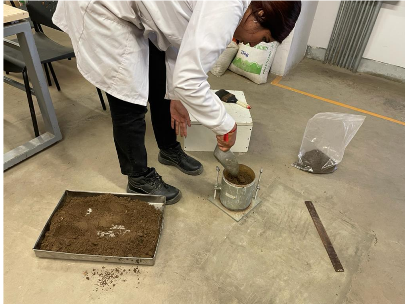
Figura 42. Llenado de material por capas
