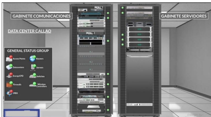
Figura 25 Consola visual datacenter
