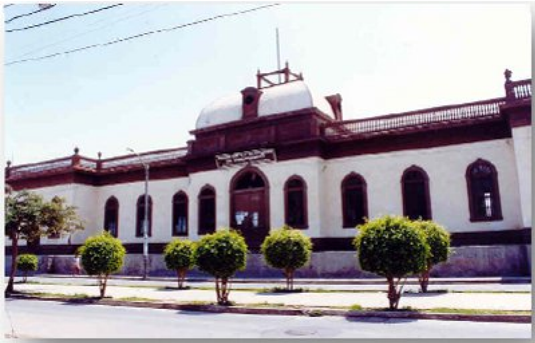
Ex Estación De Ferrocarril
