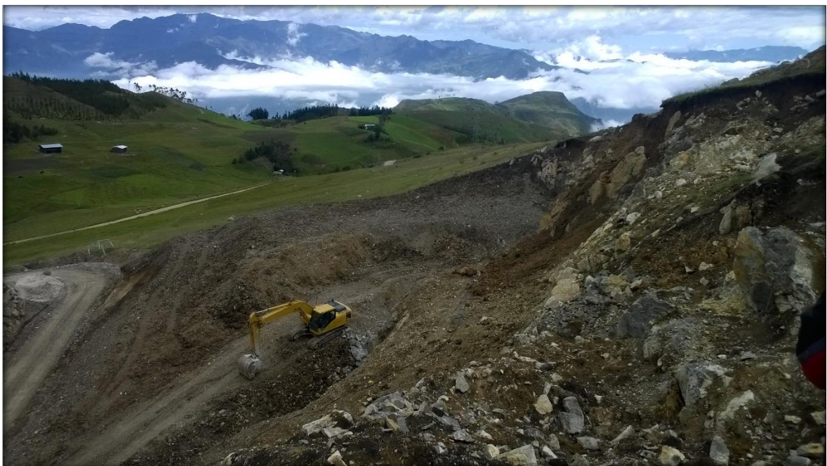
Figura N° 03: Vista panorámica de Cantera
