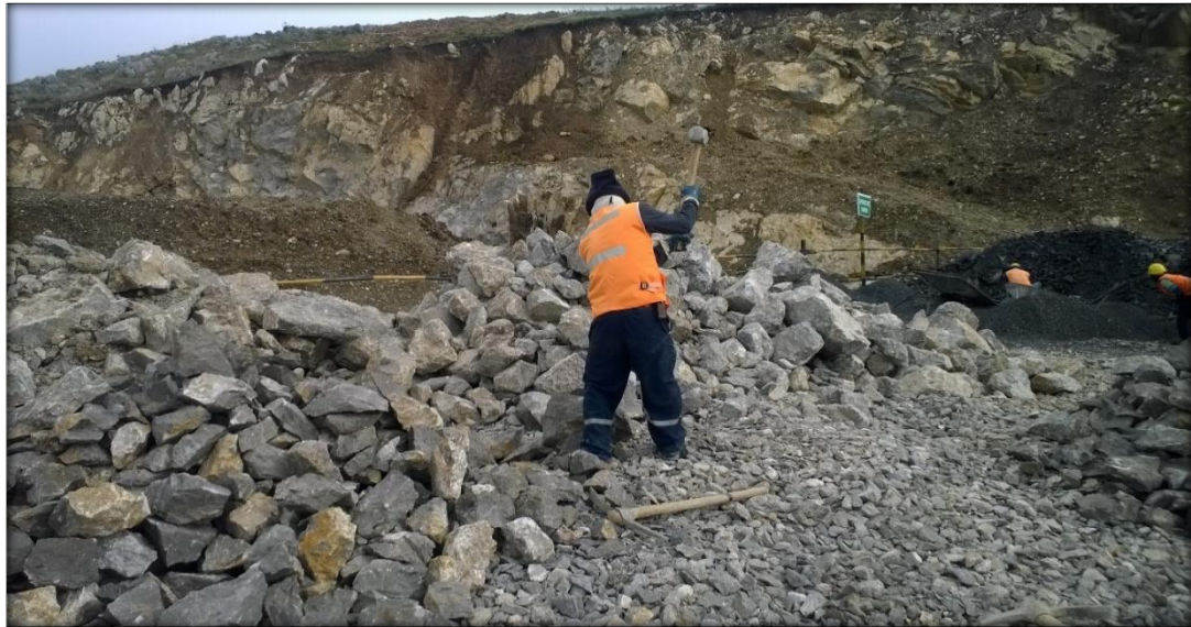
Figura N° 06: Fragmentación de Roca Caliza
