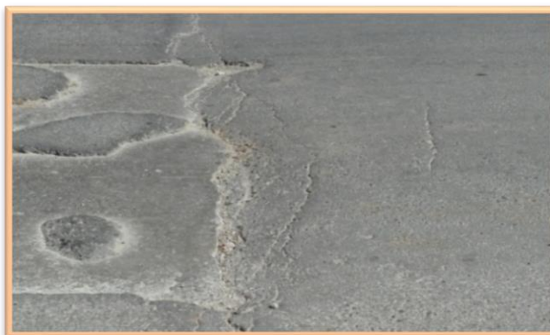
Fotografía. 04: Fisuración de la Vía de Evitamiento Norte cuadra 2
