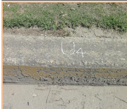
Señalizando las unidades
