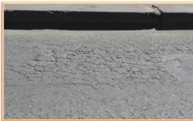
Fotografía. 04: Fisuración de la Vía de Evitamiento Norte cuadra 2
