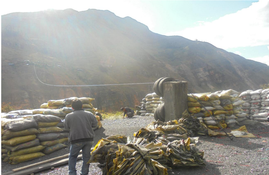
FOTO N° 6: toma de datos en el sistema de soporte de descarga
