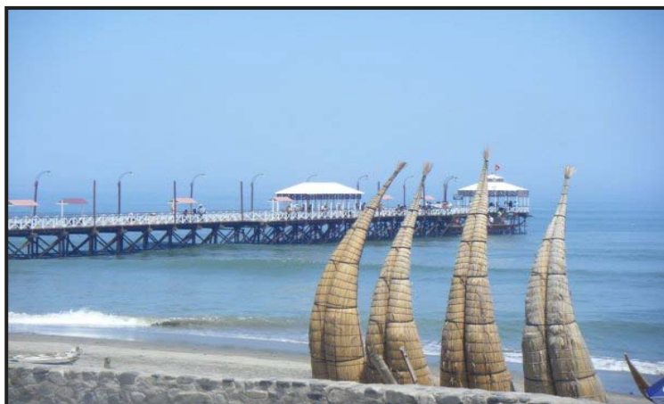
Imagen N° 01: Vista del muelle huanchaco, a la luz del día.
