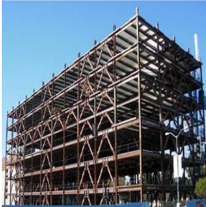
Figura 24. Vista de un edificio en construcción con pórticos arriostrados. Fuente: Francisco J. Crisafulli (2013) – Diseño sísmoresistente de construcciones de acero.
