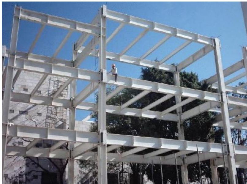
Figura 7. Perfil IPE utilizado como viga principal de los pórticos en edificio metálico.
