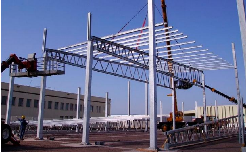
Figura 12. Montaje de una viga de celosía para conformación del pórtico estructural.
