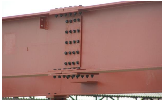
Figura 15. Conexión atornillada entre dos vigas principales. Fuente: www.luvimetal.es – Galería de imágenes.
