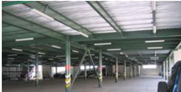
Figura 19. Uso de Losa colaborante en estacionamiento.
