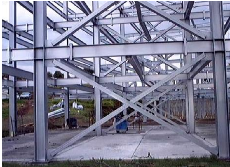
Figura 14. Cruz de San Andrés de estructura aporticada metálica.
