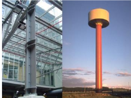
Figura 27. Ejemplos del sistema estructural columna en voladizo. Fuente: Francisco J. Crisafulli (2013) – Diseño sísmoresistente de construcciones de acero.
