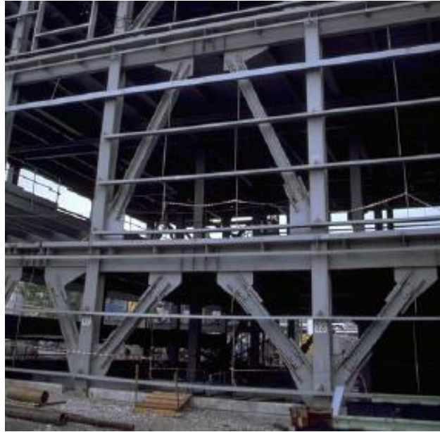
Figura 25. Construcción de un edificio de acero con pórticos arriostrados excéntricamente.
