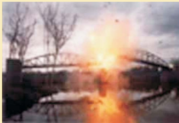
Explosión controlada para demoler un puente
