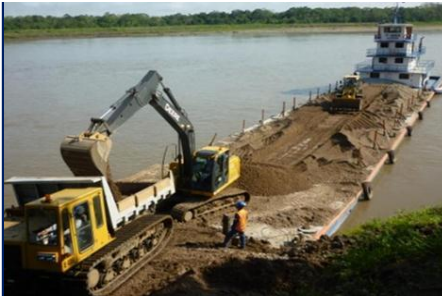
E/F. "JAED V" + A/F. "TITANIC III" CON CARGA DE RIPIO TRANSPORTE DE 2,000 M3. DE HORMIGON PARA PLATAFORMA DE EXPLORACION EN BRETAÑA-LORETO LOTE 95 RIO UCAYALI. PETROLERA GRAN TIERRA ENERGY PERU S.R.L.
