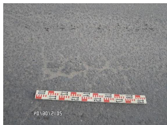
Foto 68. Piel de cocodrilo PC de severidad media con leves desgastes.
