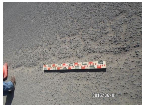
Foto 36. Piel de cocodrilo (PC) de severidad media que no interfiere con el tráfico.
