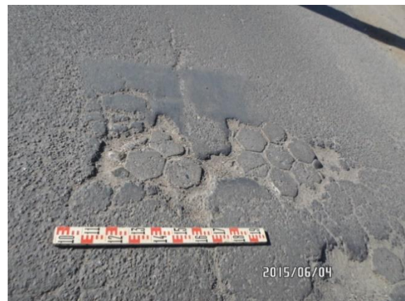
Foto 36. Piel de cocodrilo (PC) de severidad media que no interfiere con el tráfico.
