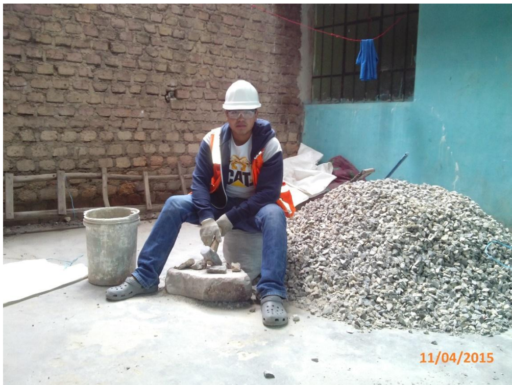
Fotografía N° 04: Chancado del agregado de roca caliza hasta convertirlo en una granulometría de 3/4"
