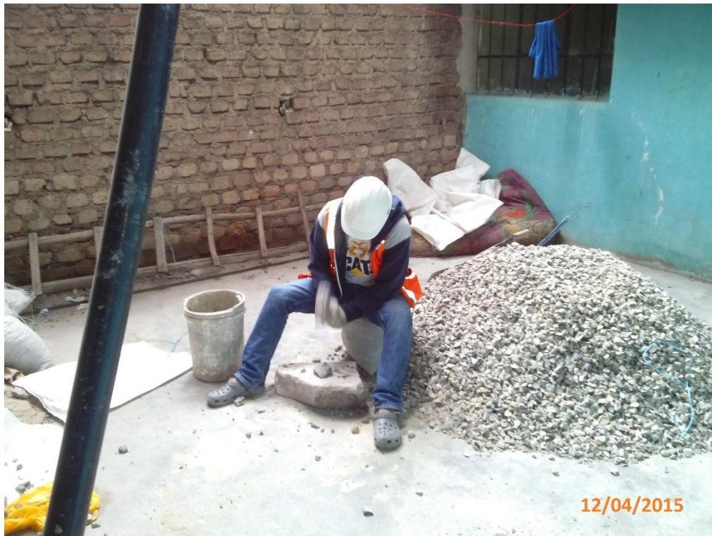
Fotografía N° 05: Chancado del agregado de roca caliza hasta convertirlo en una granulometría de \frac{3}{4} "
