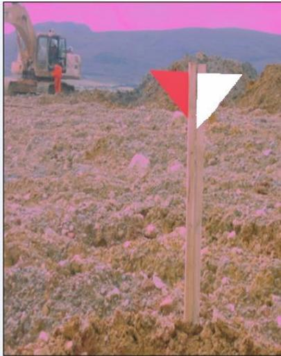
**Foto 04 Delimitación ripeo tractor – ripeo con motoniveladora.**
