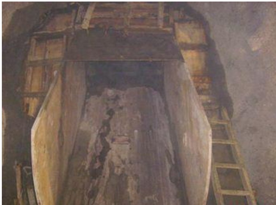
Fuente: tomado en interior mina Troy SAC.
