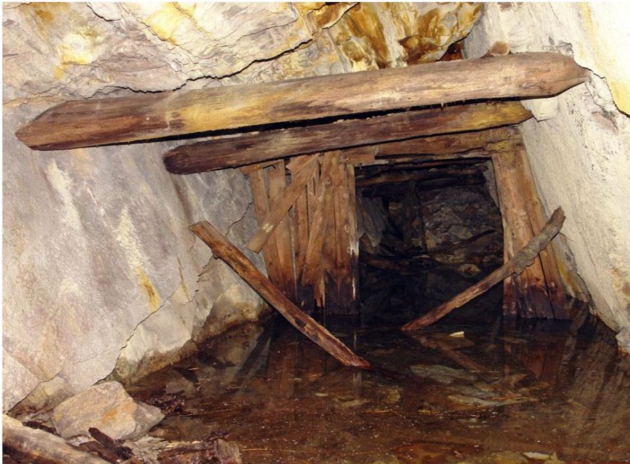
Fuente: tomado en interior mina Troy SAC.
