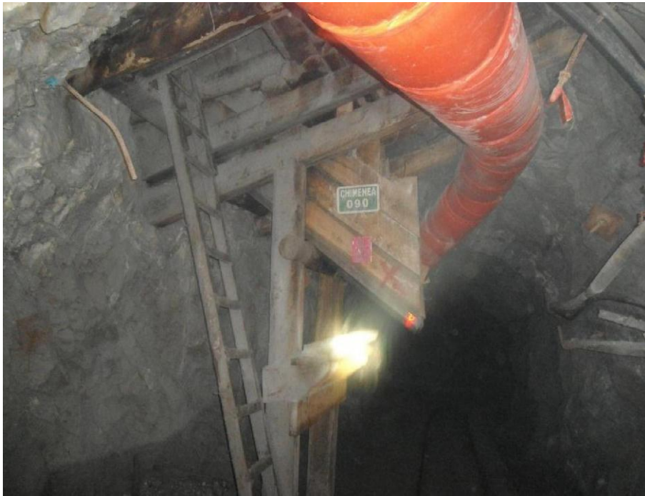
Fuente: tomado en interior mina Troy SAC.
