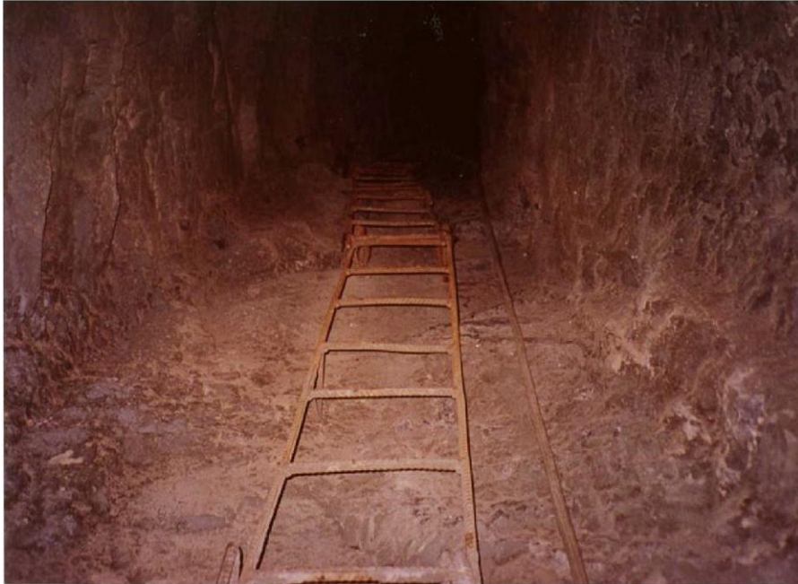
Foto N° 13 Escaleras metálicas ancladas en una chimenea PEM, Minera Troy.
