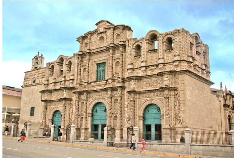
Fotografía 1: Iglesia catedral de Cajamarca, mampostería de piedra con mortero
