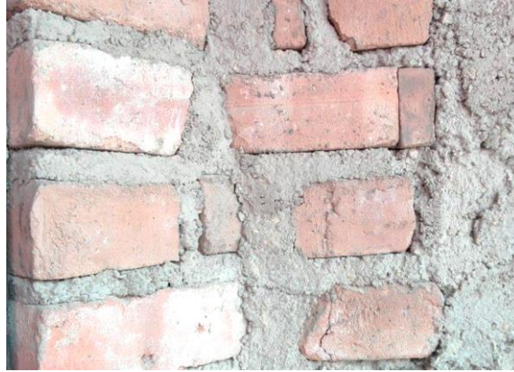
Fotografía 2: Diferentes espesores en la junta de mortero
