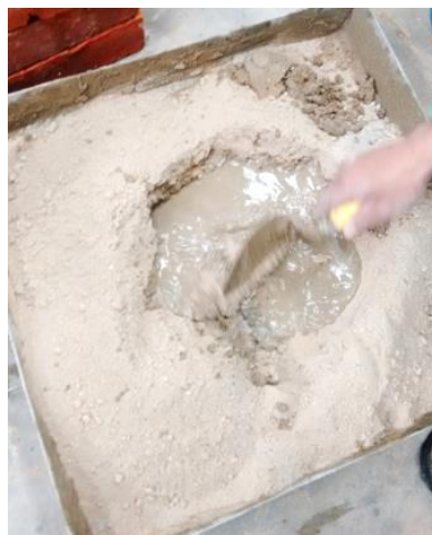
Fotografía 14: Preparación del mortero para pilas de ladrillos.
