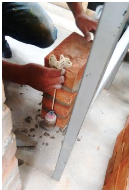
Fotografía 16: Aplomado de pila de ladrillo.
