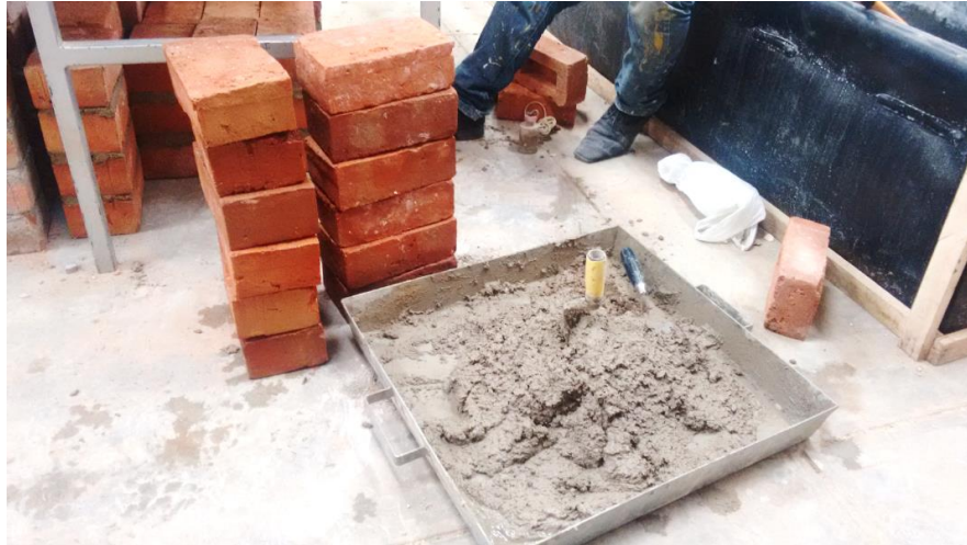
Fotografía 15: Materiales para la realización de las pilas de albañilería.
