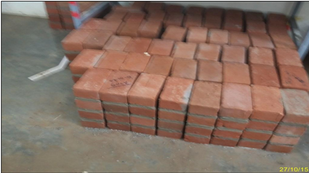
Foto N° 19 Almacenamiento y curado de pilas
