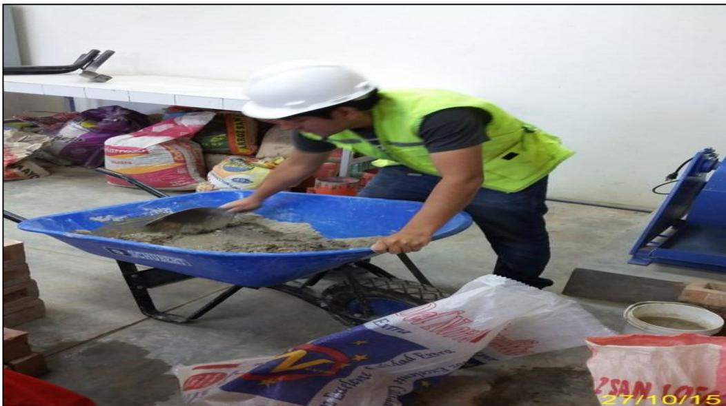
Foto N° 18 Elaboración de Mezcla de mortero
