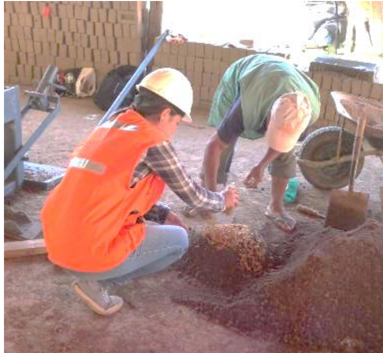
Figura 23. Mezcla de tierra y adición de viruta.
