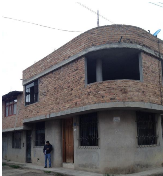
FIGURA N° 6.6 Tabiquería no confinada sobre los voladizos
