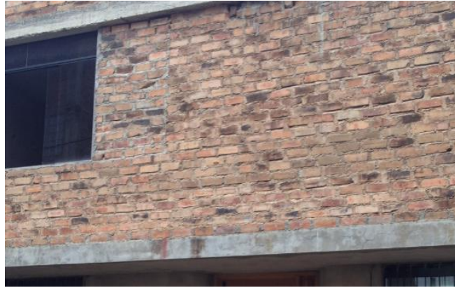
FIGURA N° 6.5.1 Tabiques completados con ladrillo crudo
