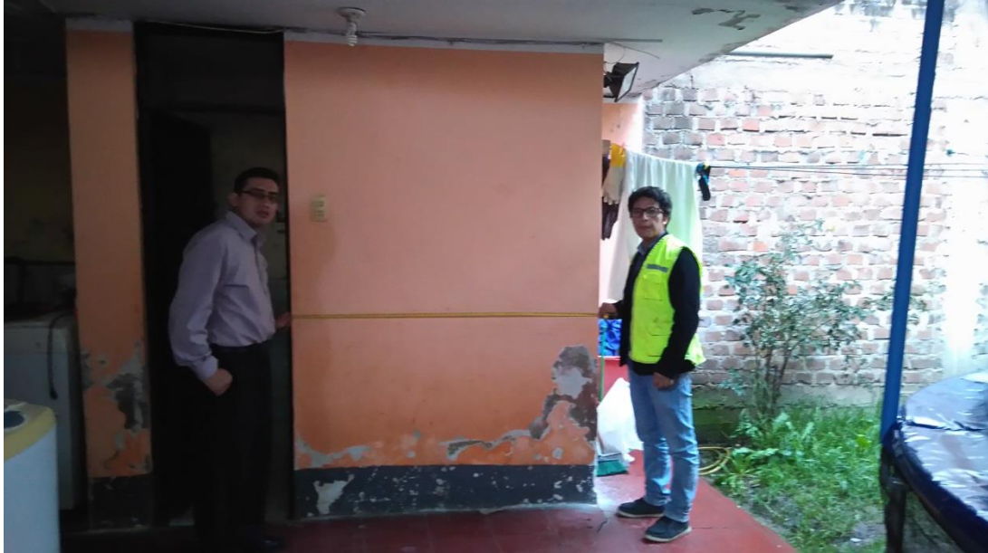
Figura N° 9.1. Longitud de muro.
