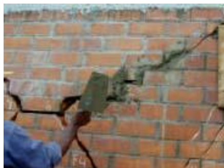
FIGURA. 8.1 Reparación de grietas gruesas
