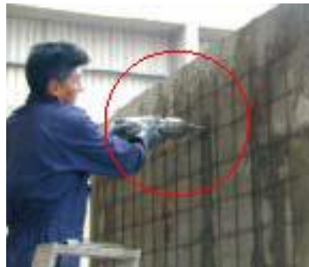
FIGURA. 8.6 Inyección de perforaciones
