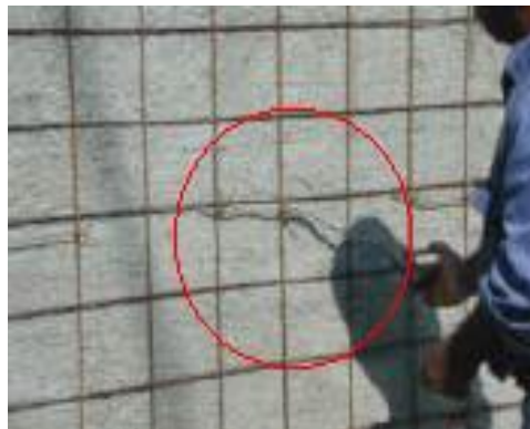
FIGURA. 8.5 Fijado de la malla electrosoldada
