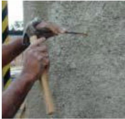
FIGURA. 8.4 Perforación del muro
