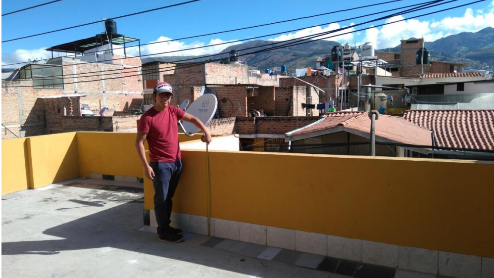
Figura N° 9.7. Medición de parapetos.
