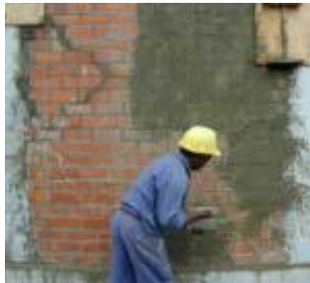
FIGURA. 8.3 Pañeteo del muro
