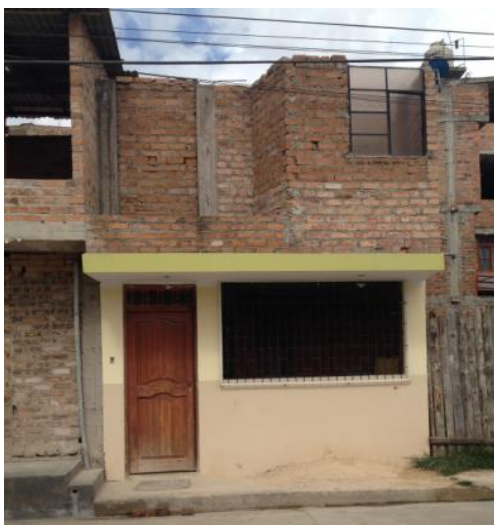
FIGURA N° 6.1 Viviendas sin junta sísmica y losas a desnivel
