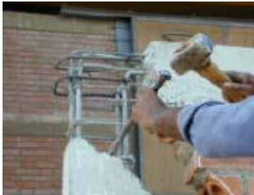
FIGURA. 8.2 Picado del nudo viga columna
