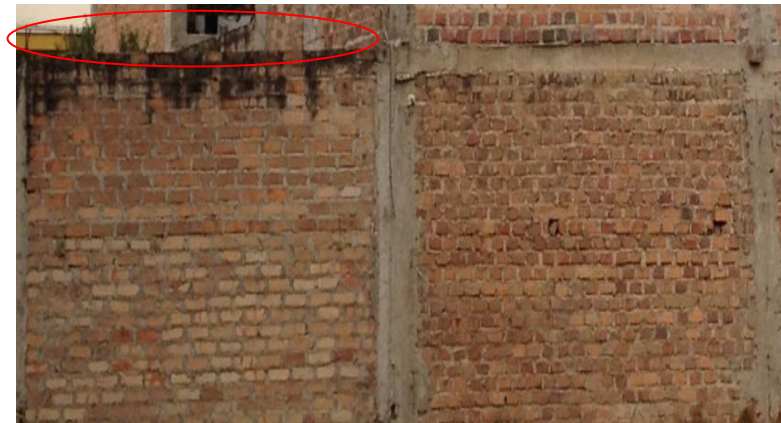
FIGURA N° 5.13 Uso de ladrillos crudos y cocidos en muro
