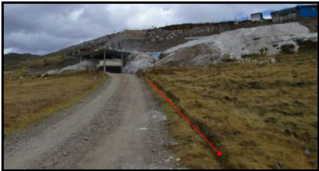
Foto 33: Cuneta de la trocha.
