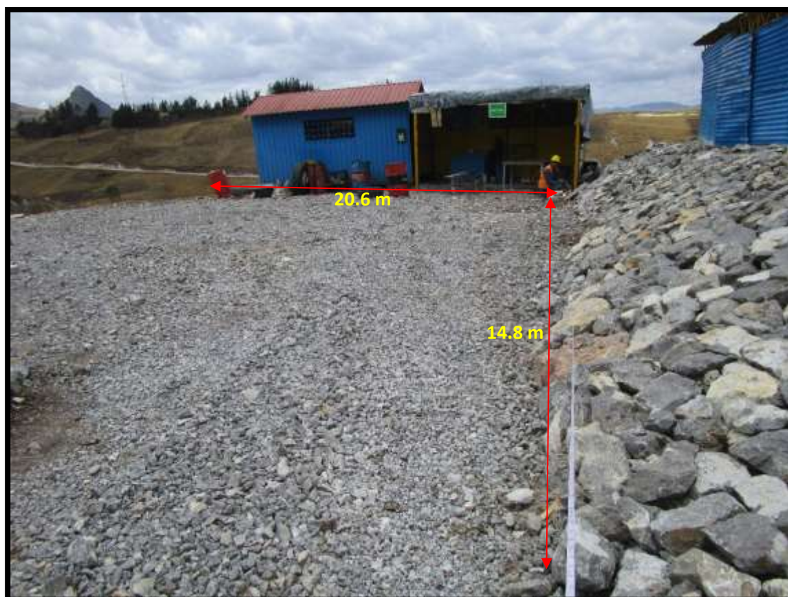
Foto 20: Patio de Maniobras.
