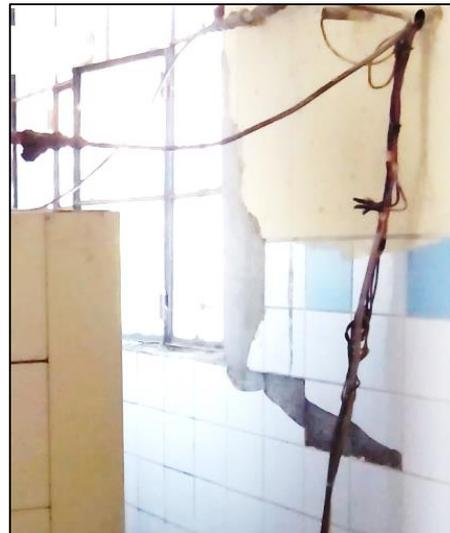
*Figura 5 y 6: Cables expuestos dentro de la Asilo de ancianos
