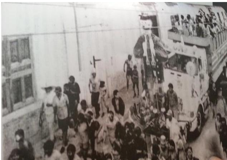
Fotografía N° 18: Entrada del Ño Carnavalón
