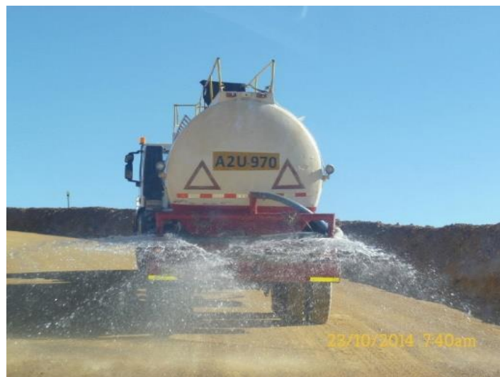
Foto N° 20 Humectación de material.
