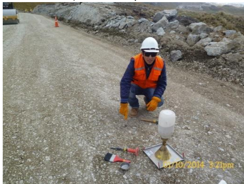
Foto N° 09 Aparato de cono y arena.
