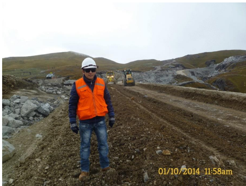
Foto N° 04 Extendido y compactado del material afirmado.
