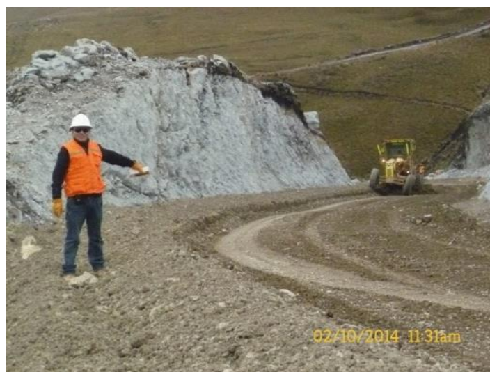
Foto N° 17 Extendido de material.
