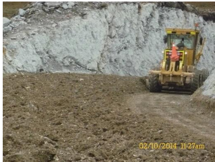
Foto N° 16 Extendido de material.
