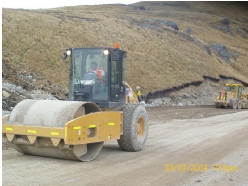
Compactación de material.
