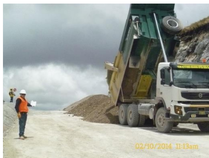
Foto N° 15 Colocación de material afirmado.
