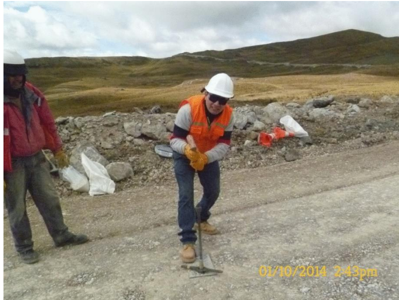
Foto N° 07 Ensayo con densímetro nuclear.
