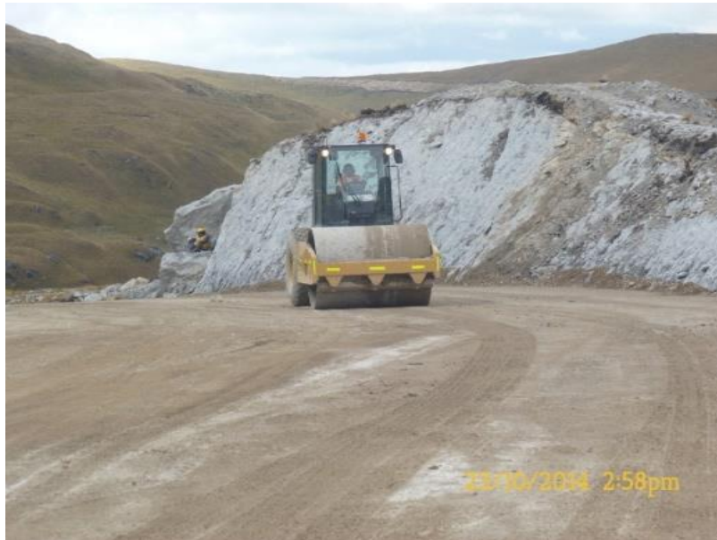
Compactación de material.
