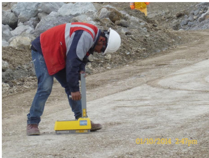
Foto N° 08 Ensayo con densímetro nuclear.
