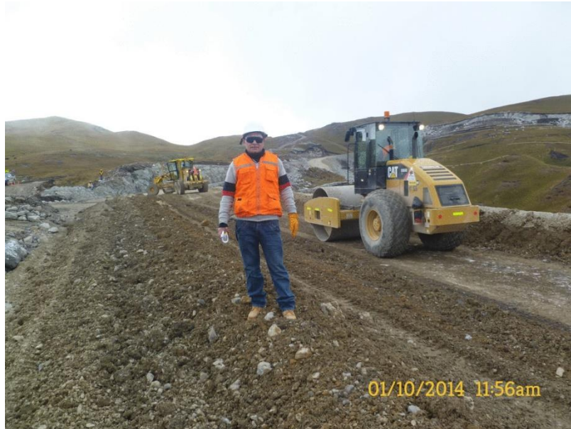
Foto N° 03 Extendido y compactado del material afirmado.
