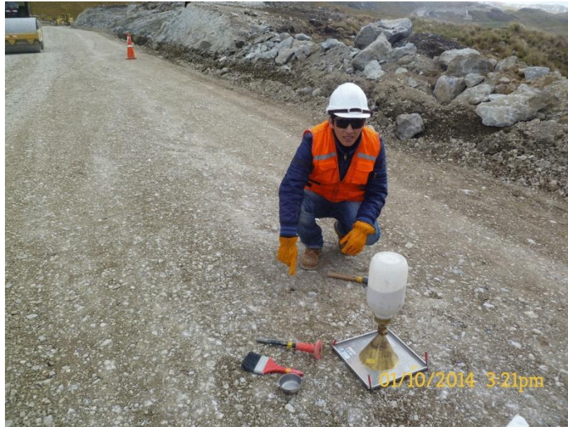
Foto N° 15 Realizando el ensayo de cono de arena.
