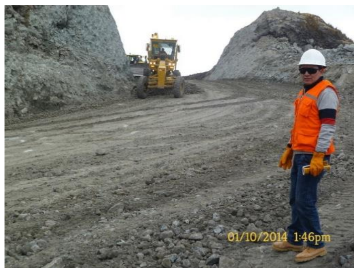
Foto N° 19 Batido de material.
