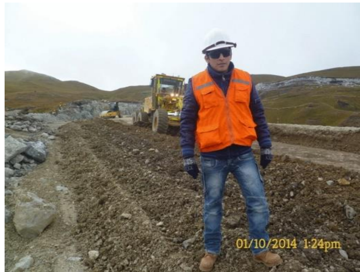
Foto N° 18 Batido de material.
