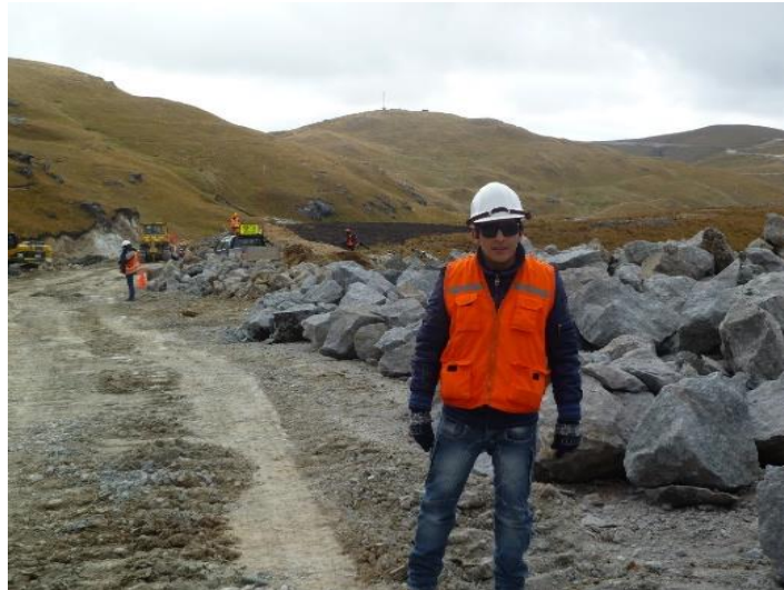
Foto N° 14 Preparación de la subrasante.
