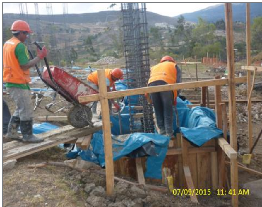
FOTO N°06: Vaciado de concreto en zapatas
