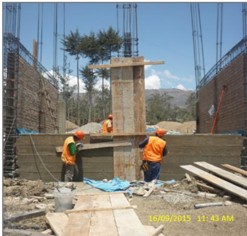
FOTO N°08: Encofrado de columnas
