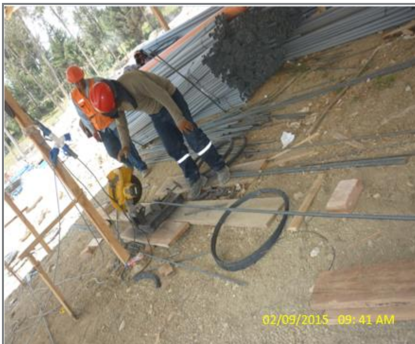
FOTO N° 02: Habilitación del acero para Zapatas
