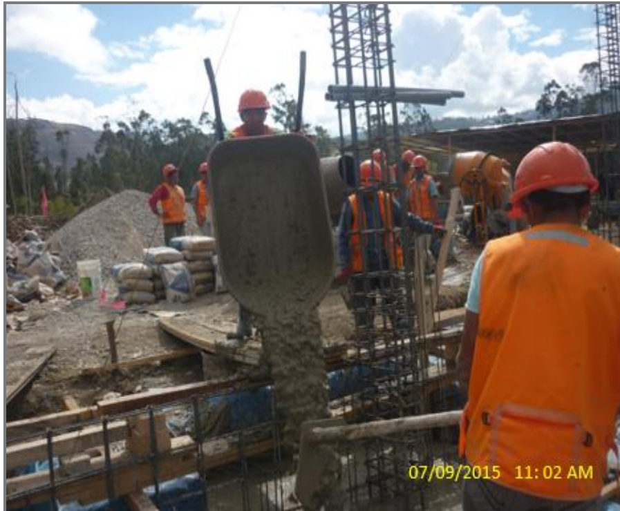
FOTO N°5: Vaciado de concreto en zapatas
