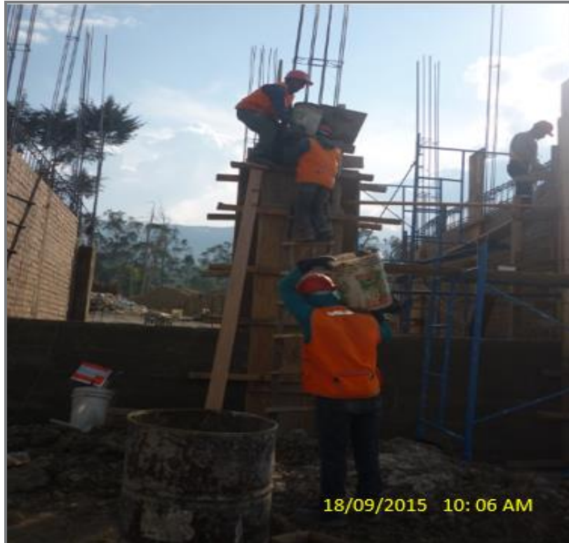
FOTO N° 09: Concreto en columnas
