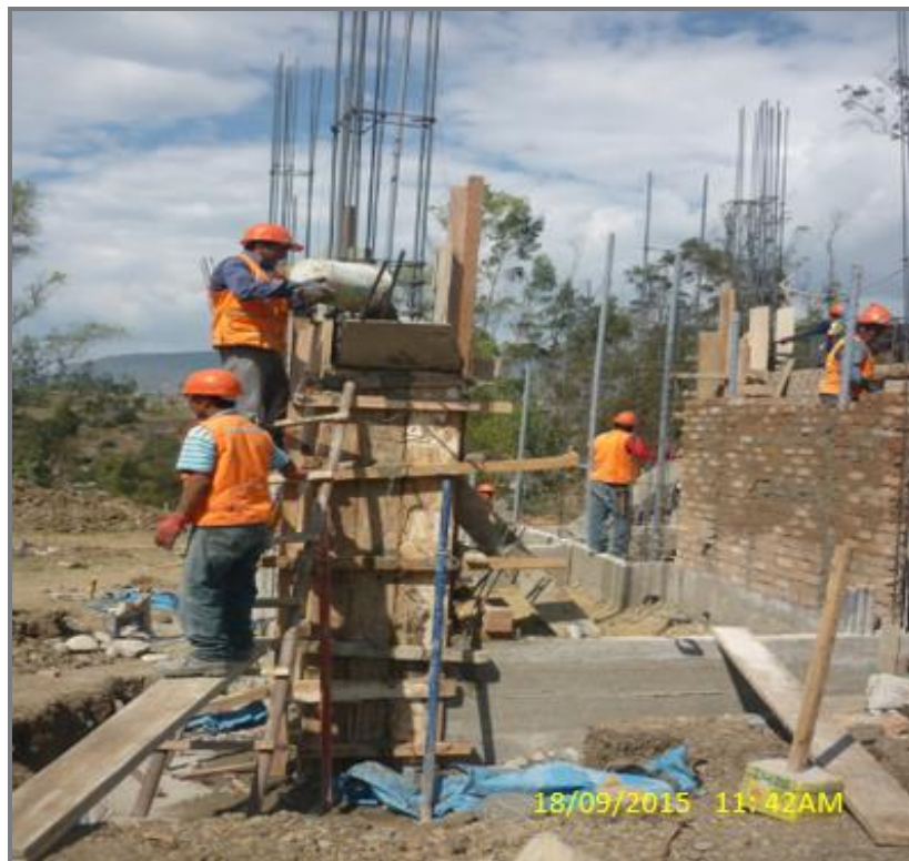
FOTO N°10: Concreto en columnas
