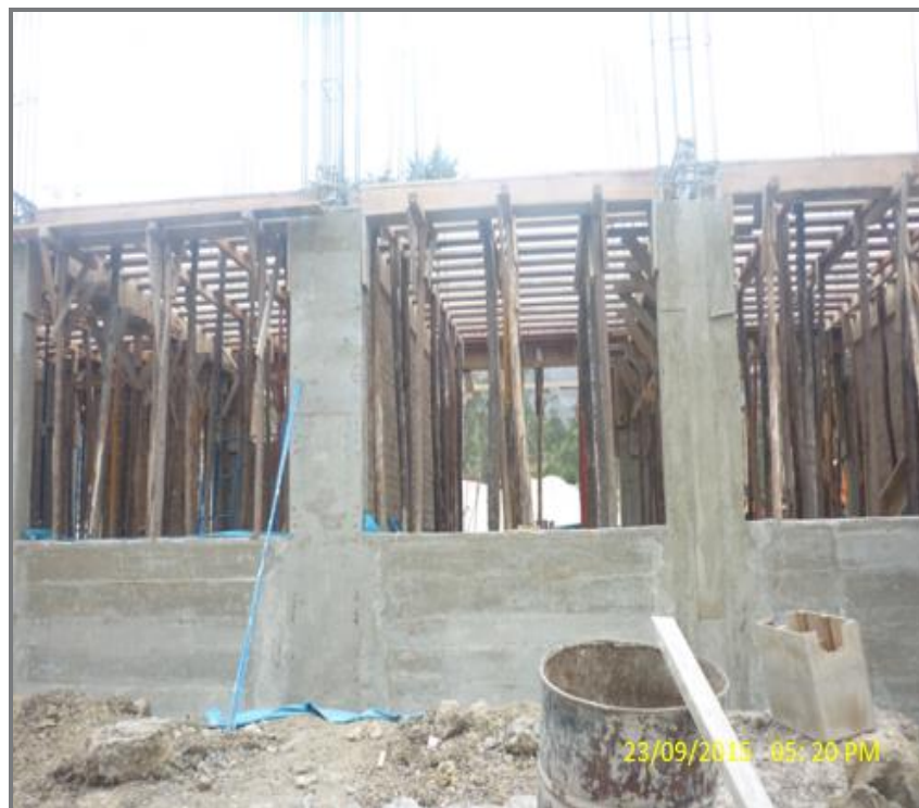
FOTO N° 12: Encofrado losa aligerada
