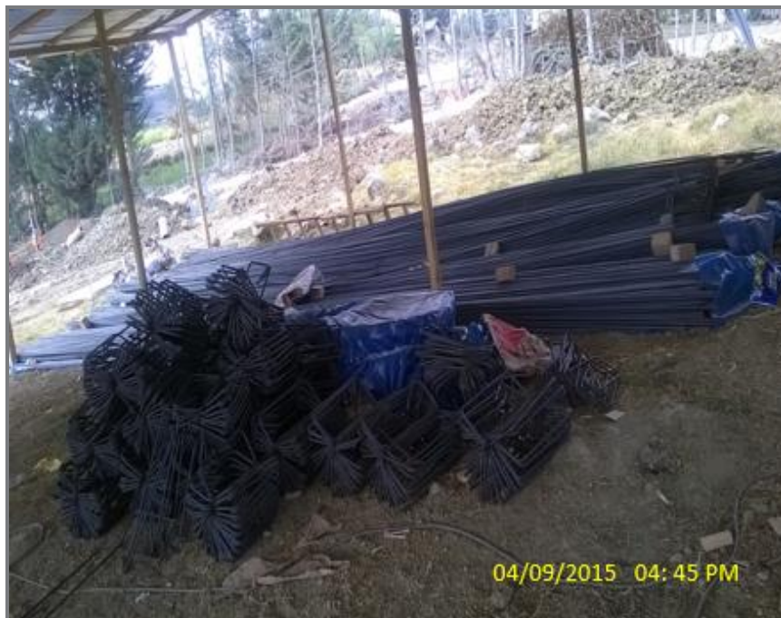
FOTO N° 04: Habilitación del acero para columnas
