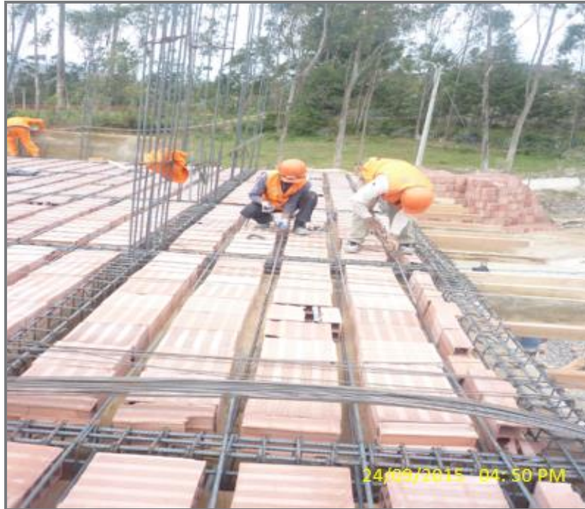
FOTO N° 13: Acero en losa aligerada
