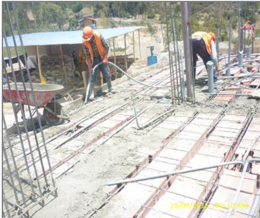
FOTO N°14: Vaciado de concreto en vigas
