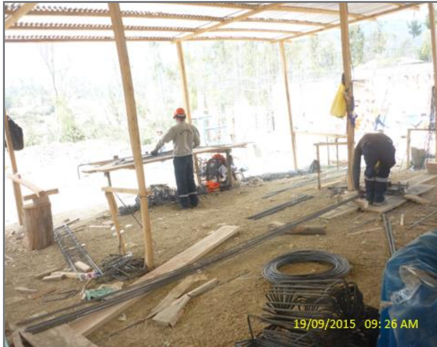
Figura 07 N°: Habilitación del acero para vigas
