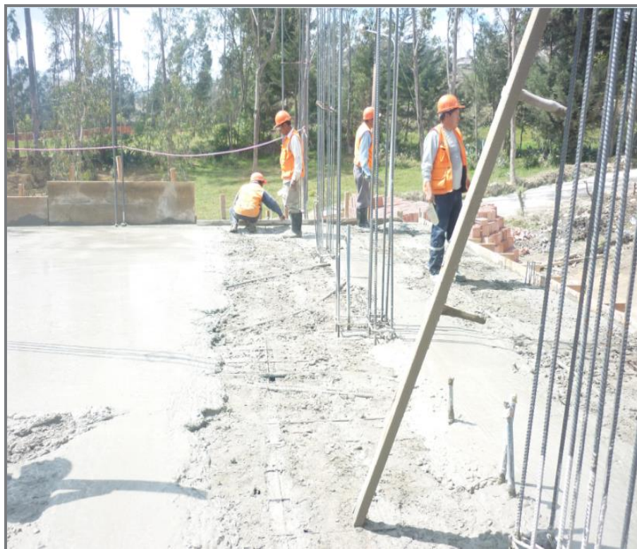
FOTO N° 16: Vaciado de concreto en la losa aligerada
