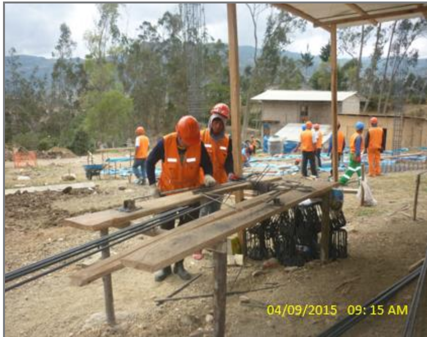
FOTO N° 03: Habilitación del acero para columnas
