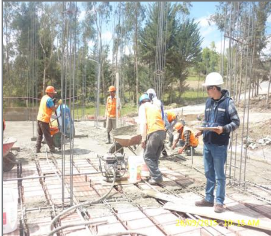
FOTO N° 15: Vaciado de concreto en la losa aligerada
