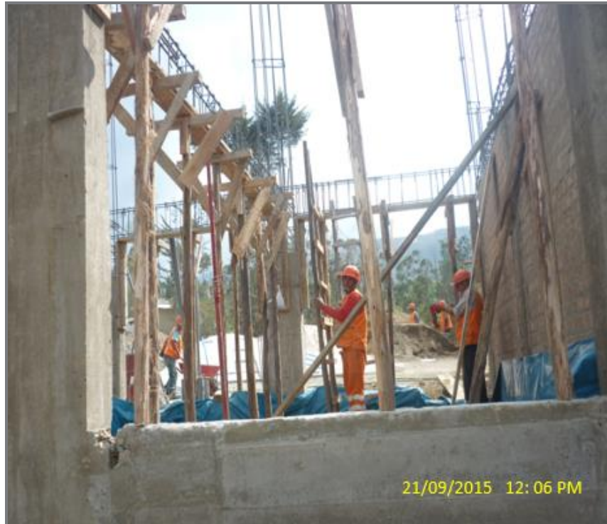
FOTO N° 11: Encofrado en vigas
