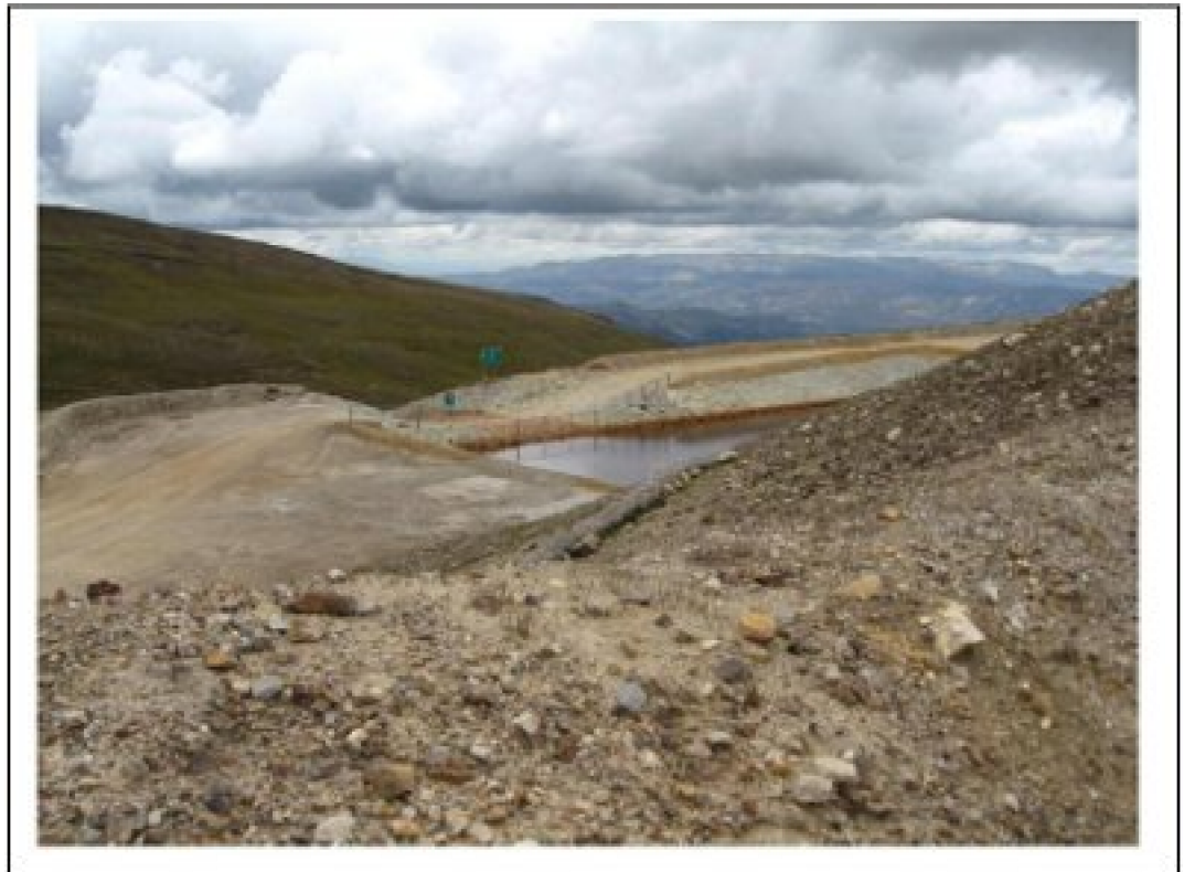
Figura 13: Visita de Campo del recorrido del tendido de la línea de Alta Tensión
