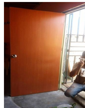
Figura 06: Colocación de puerta nueva
