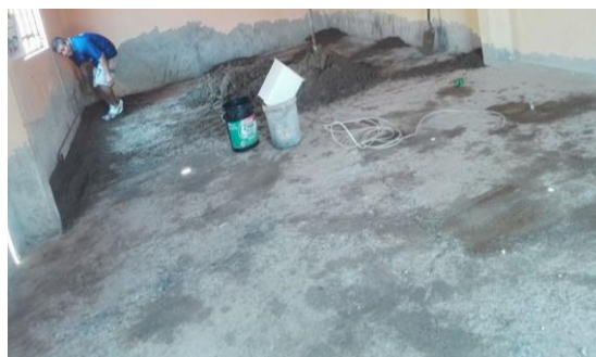
Figura 03: Construcción del piso
