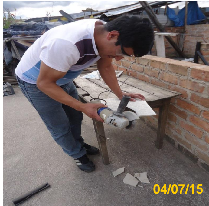
FOTO N° 13: Haciendo los cortes de los vertederos.
