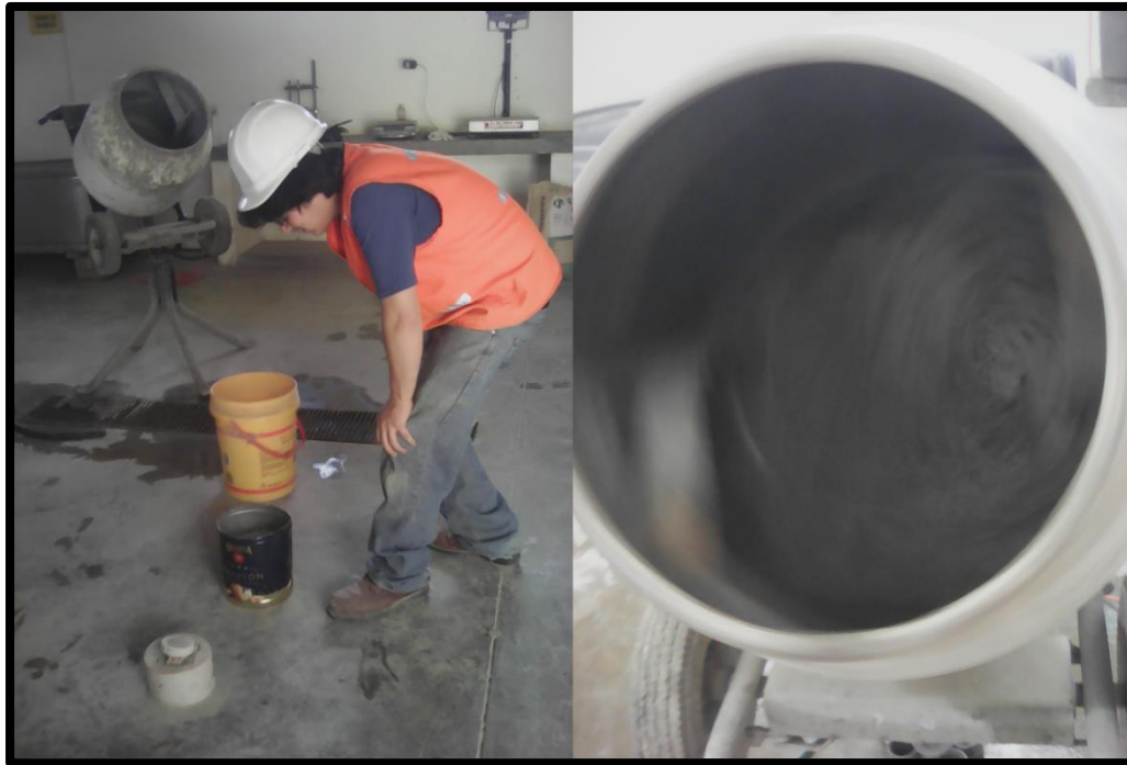
FOTOGRAFIA N° 46 Preparación de materiales y elaboración de la mezcla de concreto
