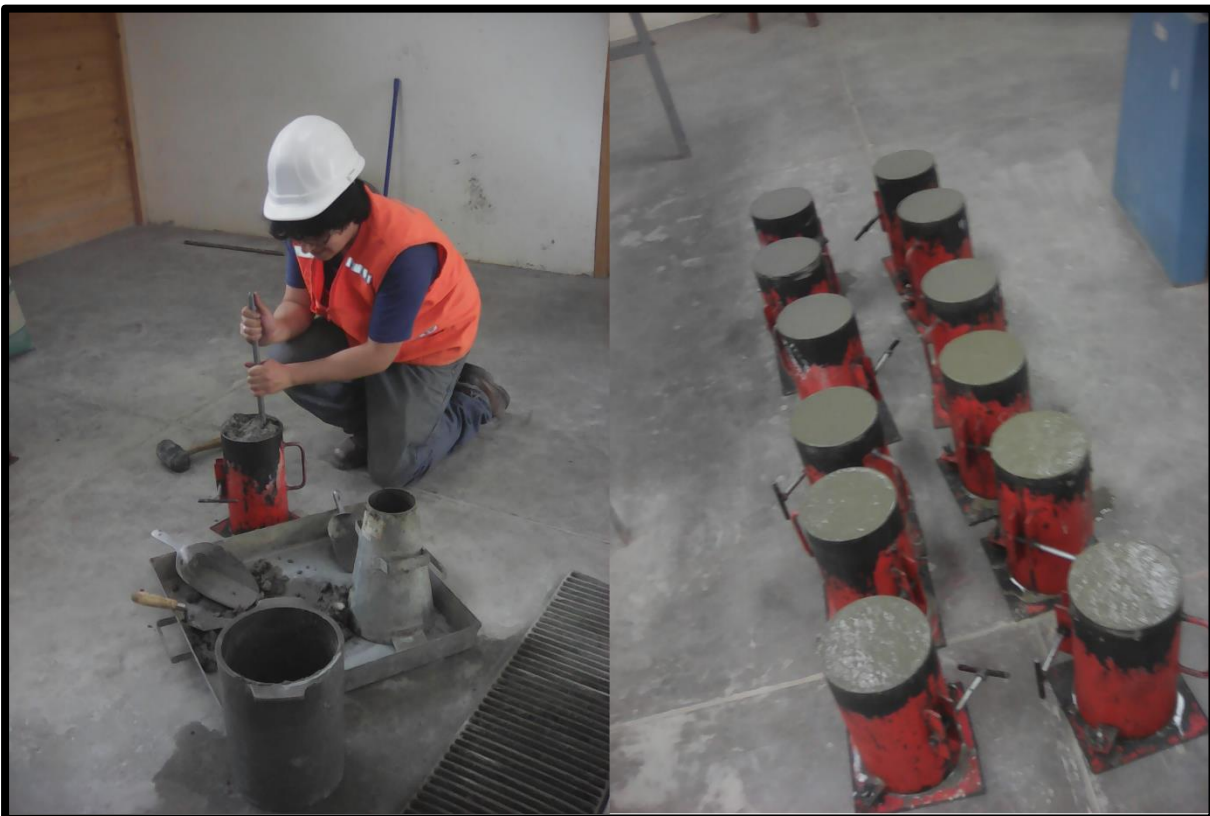
FOTOGRAFIA N° 49 Realizando el llenado y enrazado de probetas de concreto fresco
