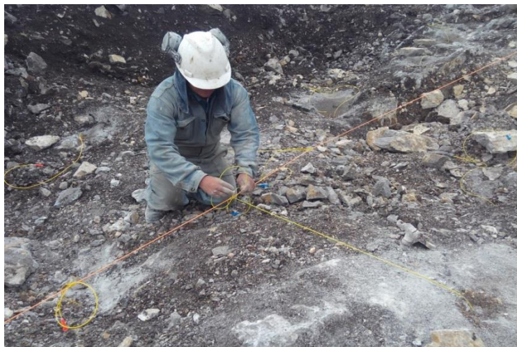
Figura N° 22 Activación del cordón detonante
