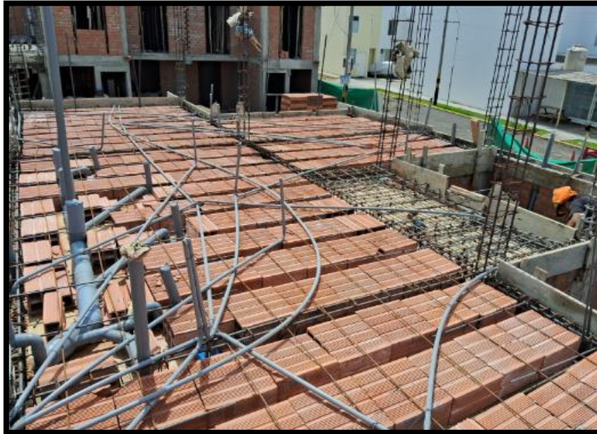
Sector 3, actividad 1 (armado de desagüe en techo del primer piso) y actividad 2 (tendido de tubería de luz para techo del primer piso) en módulo 2.
