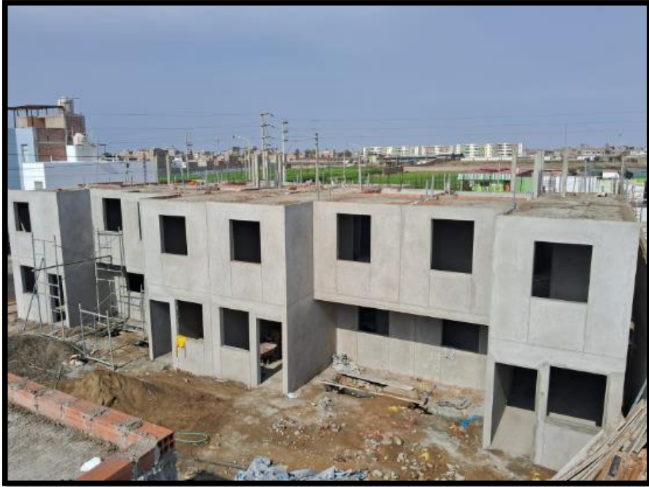
Vista frontal del pasaje B del conjunto de viviendas Mz Ñ en las Brisas de Santa Clara
