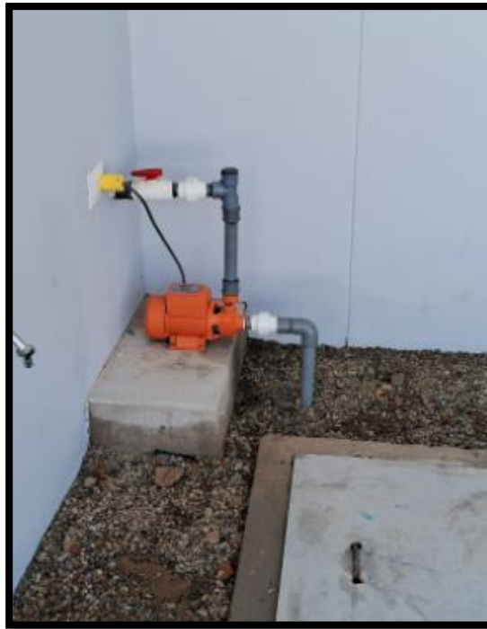
Trabajo terminado en el sector 8, que consistió en la instalación de red de agua para bombas.
