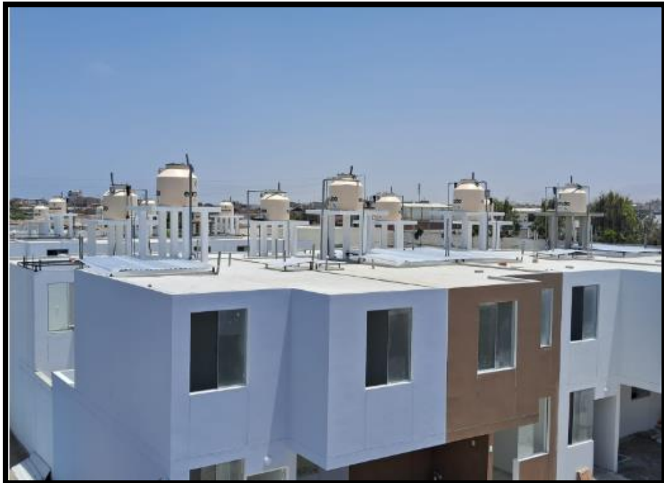
Vista de los tanques elevados instalados en los módulos.
