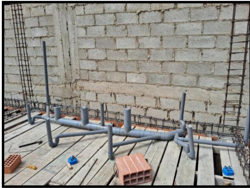
Armado de red de desagüe del segundo piso, perteneciente al sector S3
