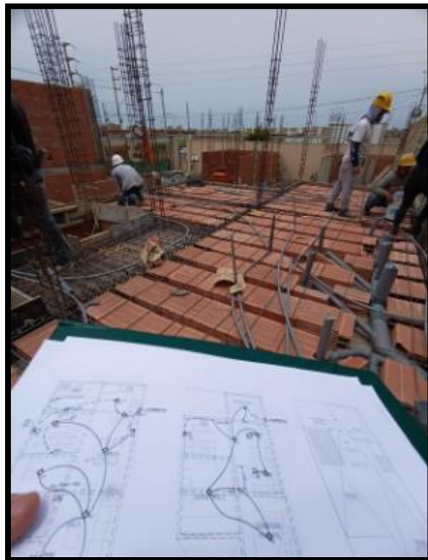
Verificación del tendido de tubería de luz en losa aligerada del primer piso perteneciente al Sector 3 - actividad 2.
