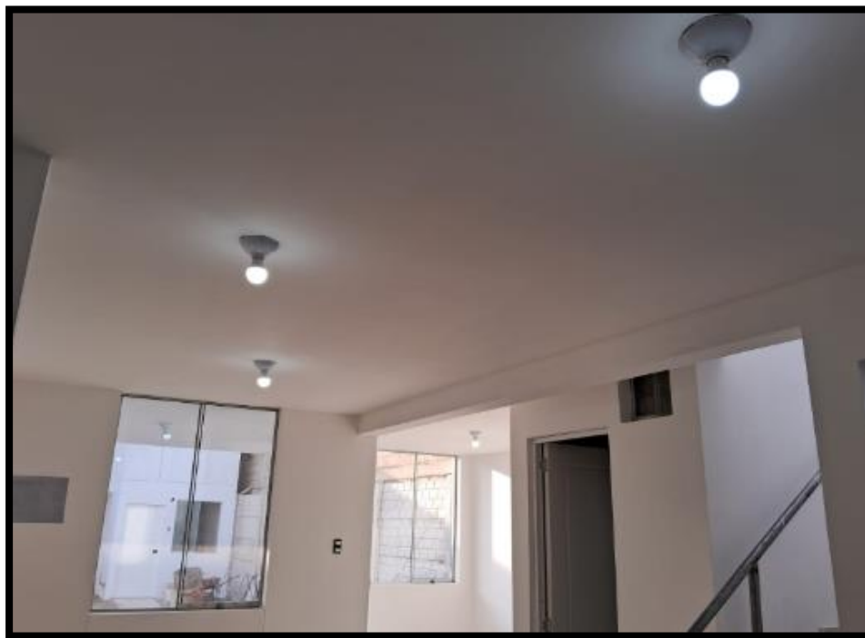
Instalación de accesorios y prueba eléctricos.
