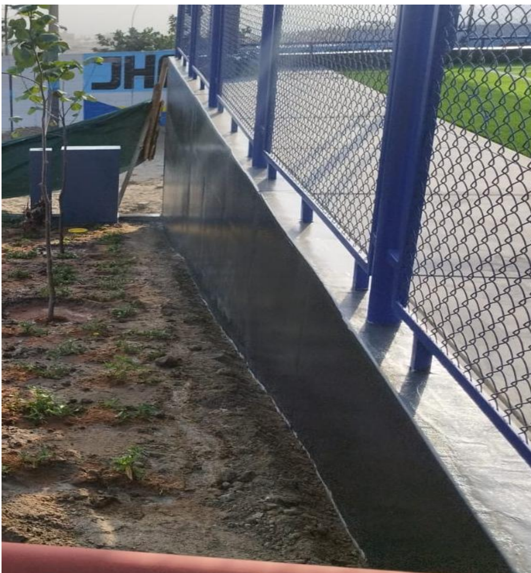
Anexo 11. Fotografía del Acabado de Muros y Cerco Metálico.
