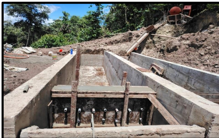
ANEXO 38. Imagen donde se visualiza vaciado de concreto en muro cortina de Sedimentador - PTAP
