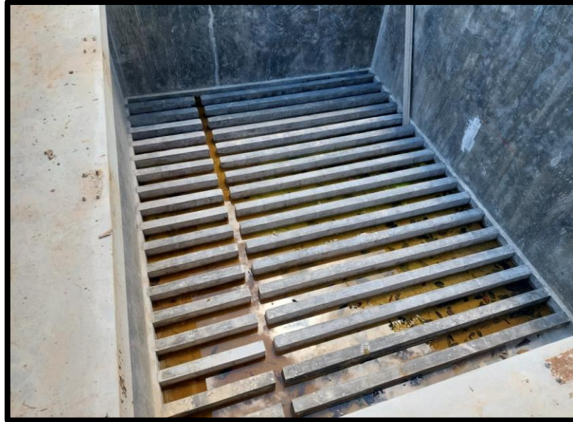
ANEXO 36. Imagen donde se visualiza el asentado de ladrillo en Filtro Lento – PTAP
