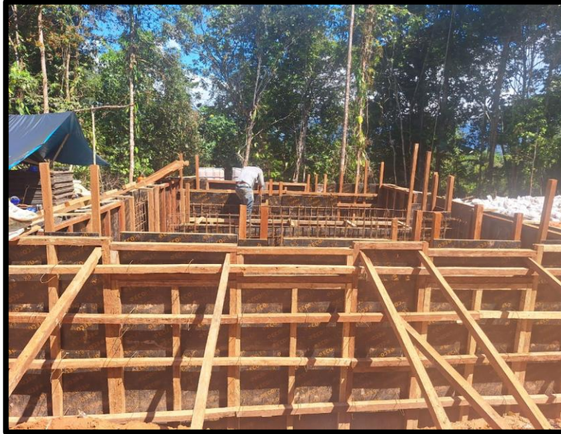
ANEXO 32. Imagen donde se visualiza el encofrado de muros en Perfiltro-PTAP.
