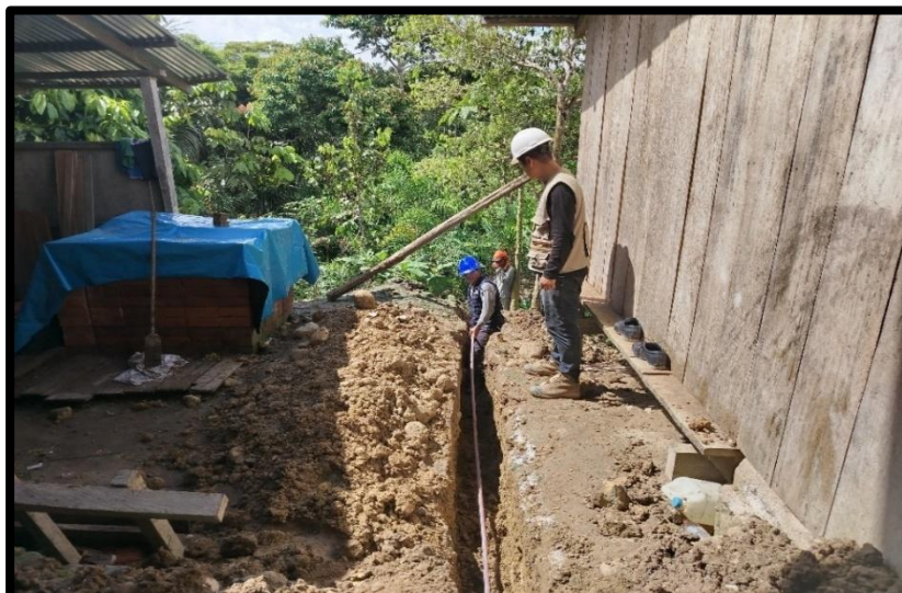
ANEXO 25. Imagen donde se visualiza las instalaciones de tubería en conexiones domiciliarias.
