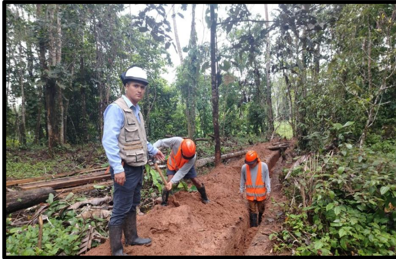
ANEXO 22. Imagen donde se visualiza el relleno de zanja en línea de conducción.
