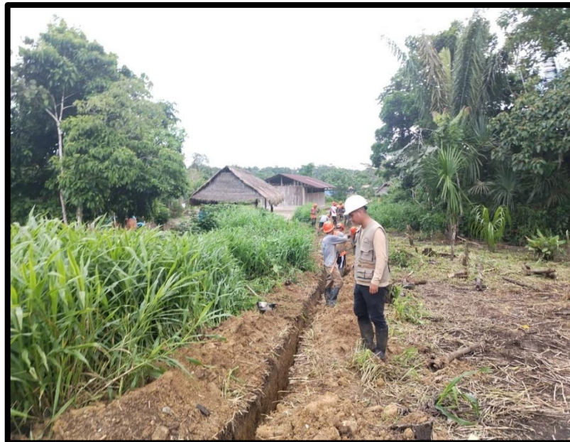
ANEXO 23. Imagen donde se aprecia la excavación en la red de distribución.
