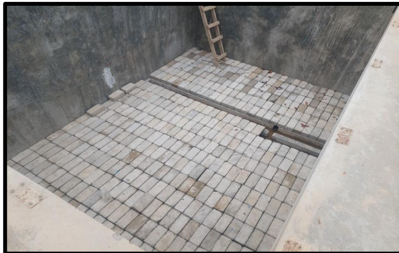
ANEXO 37. Imagen donde se visualiza la colocación de ladrillo superpuestos en Filtro Lento - PTAP
