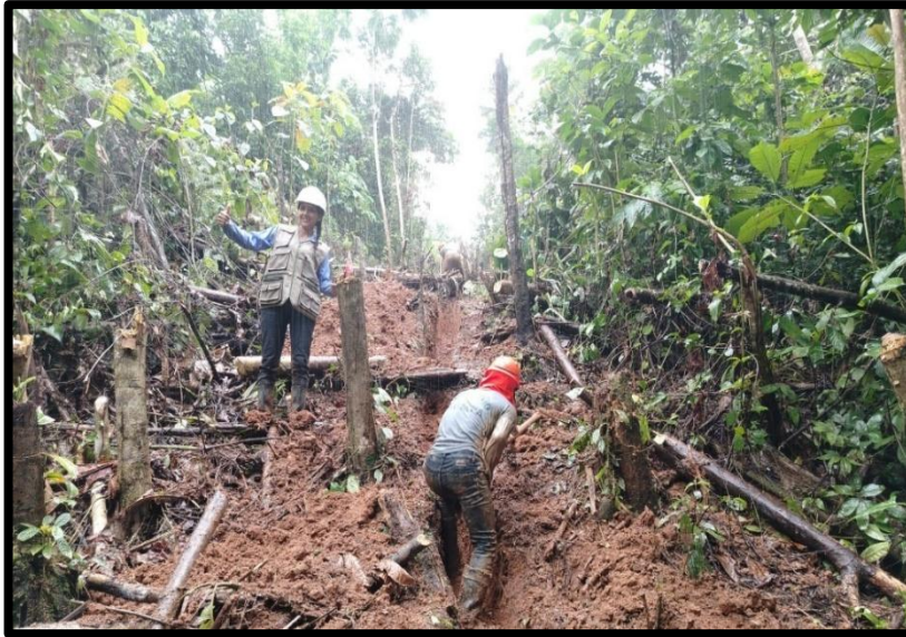
ANEXO 20. Imagen donde se visualiza las excavaciones con el personal obrero en la línea de conducción.
