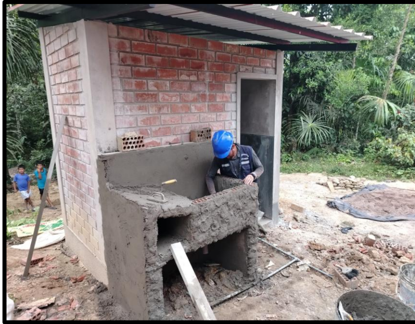
ANEXO 28. Imagen donde se observa el tarrajeo en lavatorio de UBS.
