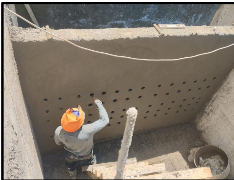
ANEXO 33. Imagen donde se visualiza el tarrajeo de muro en Perfitro-PTAP.
