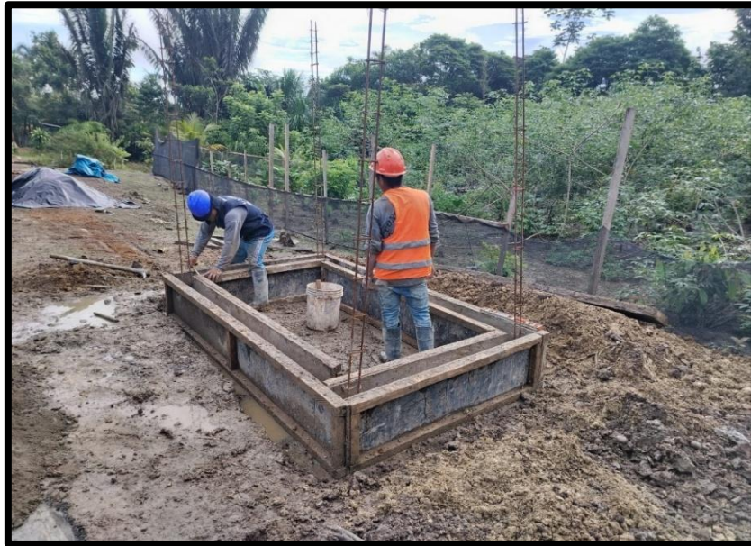
ANEXO 26. Imagen donde se visualiza el encofrado de sobrecimiento en UBS.
