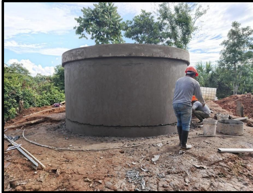
ANEXO 30. Imagen donde se visualiza el tarrajeo exterior en reservorio.
