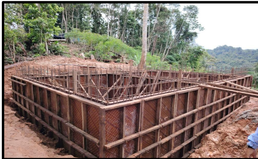
ANEXO 35. Imagen donde se visualiza el encofrado de muros en Filtro Lento – PTAP
