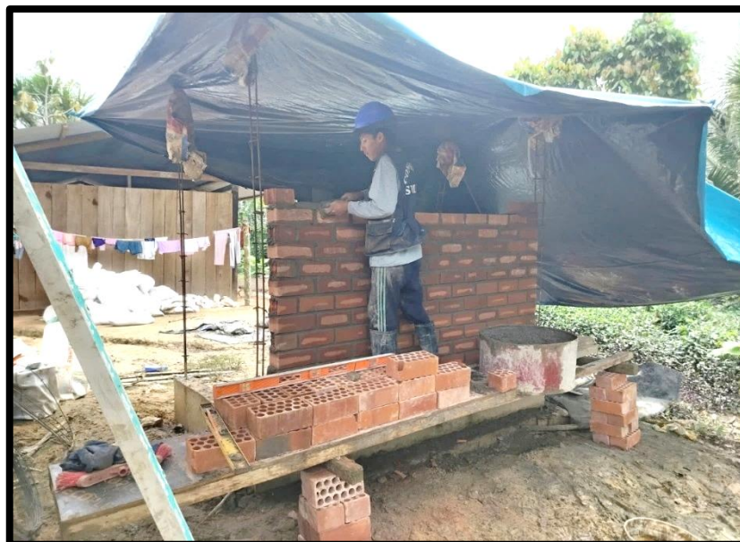
ANEXO 27. Imagen donde se visualiza el asentado de ladrillo en muro de UBS.
