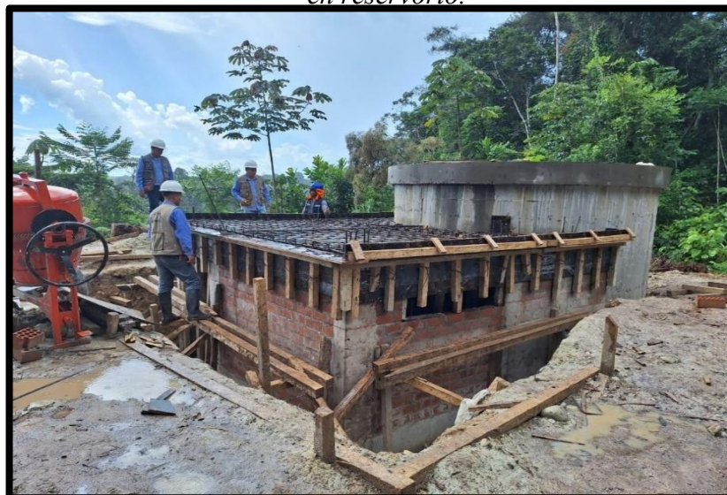
ANEXO 31. Imagen donde se visualiza el armado de acero en losa de caseta en reservorio.
