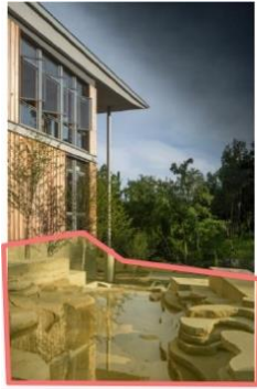
Fotografía exterior centro ambiental Frick
