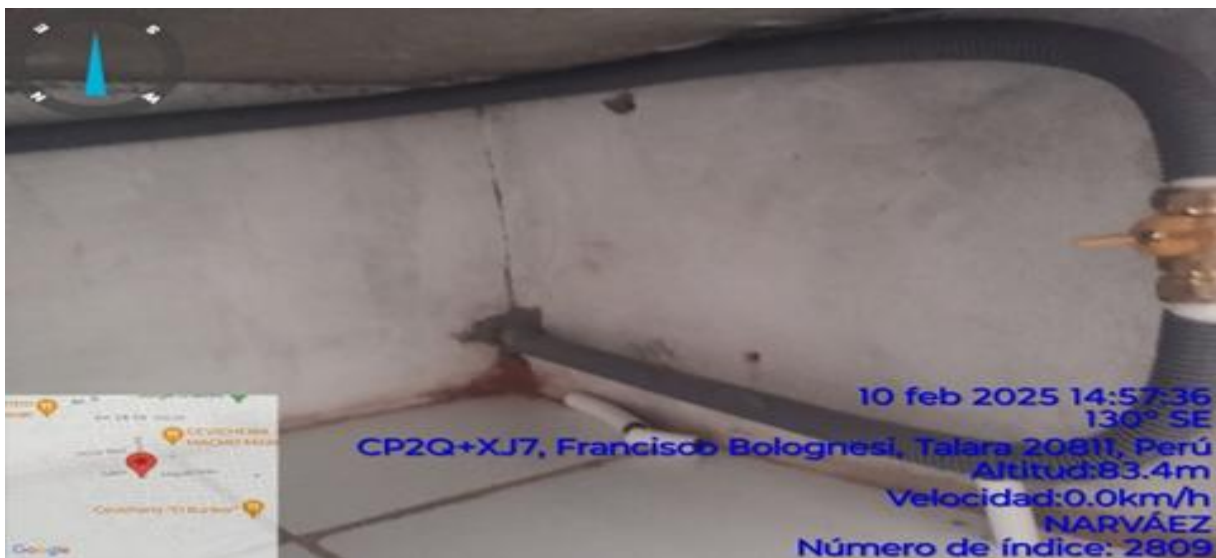
Instalación de la red interna de PeAlpe
