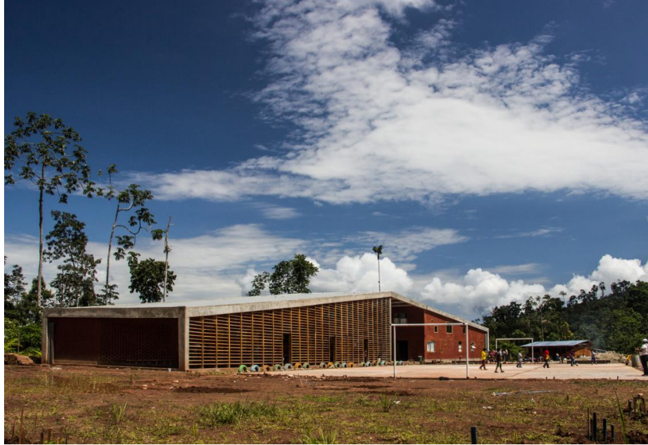
Imagen: Volumetría que garantiza correcta ventilación cruzada
